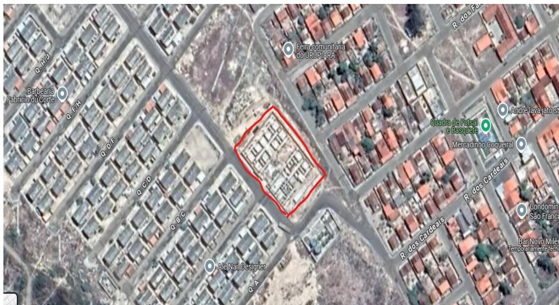
Figura 1 – Área destinada à retomada da construção
