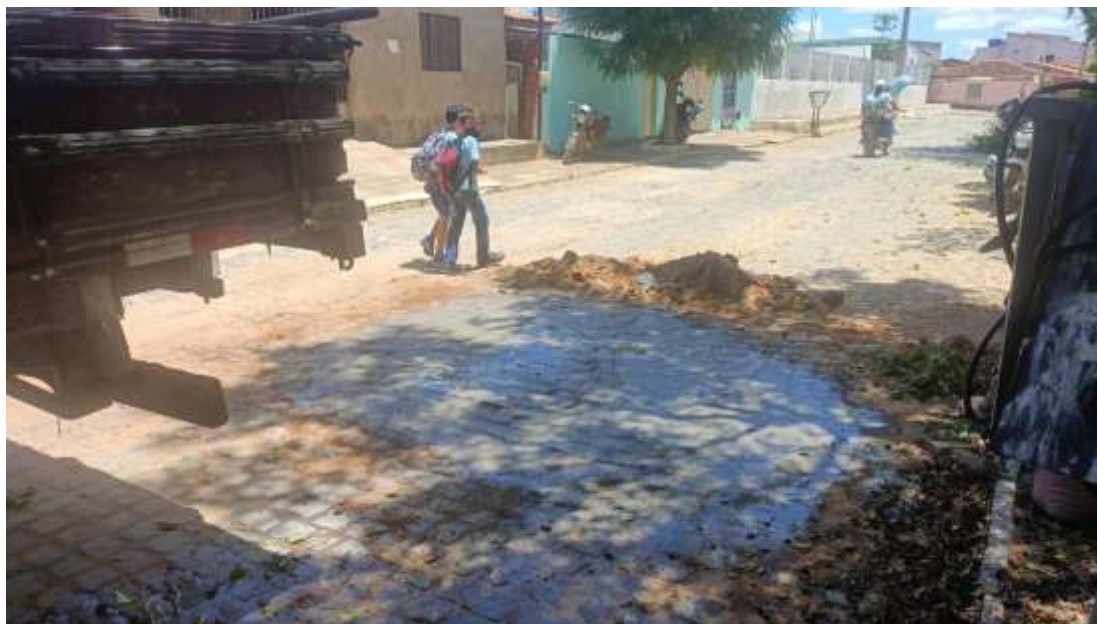
Imagem 01 – Exemplo de reassentamento de paralelepípedo
