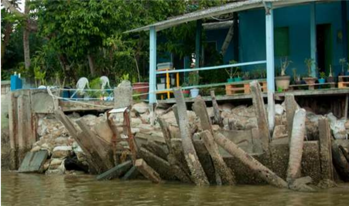
IMAGEM 8 – SACOS DE ARGAMASSA, MURO E ESTACAS NA EXTREMIDADE NORDESTE DO MURO
