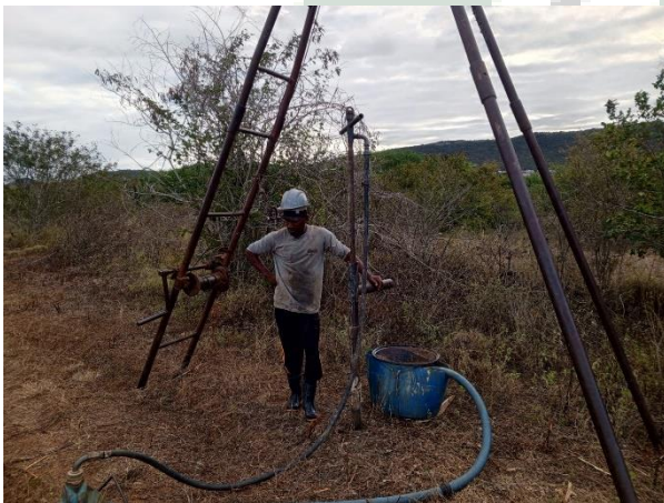
Foto 09 EXECUÇÃO DE SONDAGEM À PERCUSSÃO (SPT).
