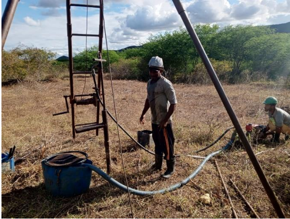
Foto 07 EXECUÇÃO DE SONDAGEM À PERCUSSÃO (SPT).
