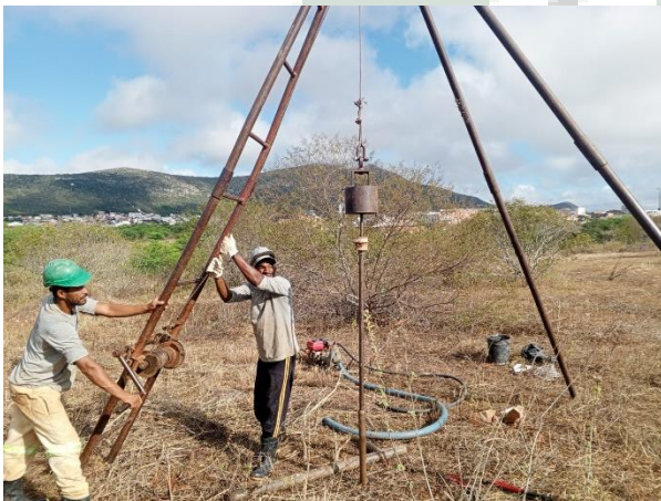
Foto 15 EXECUÇÃO DE SONDAÇÃO À PERCUSSÃO (SPT).
