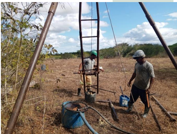
Foto 17 EXECUÇÃO DE SONDAÇÃO À PERCUSSÃO (SPT).
