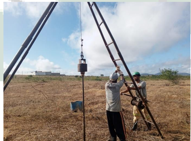
Foto 06 EXECUÇÃO DE SONDAGEM À PERCUSSÃO (SPT).
