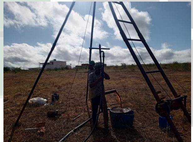
Foto 10 EXECUÇÃO DE SONDAGEM À PERCUSSÃO (SPT).
