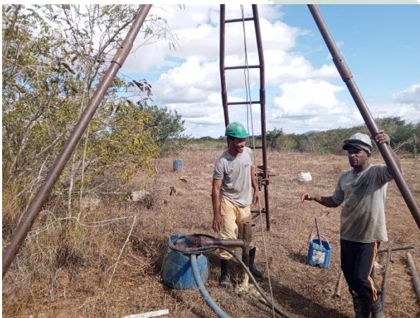
Foto 05 EXECUÇÃO DE SONDAGEM À PERCUSSÃO (SPT).
