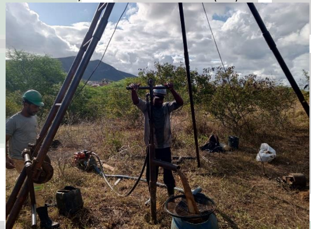
Foto 04 EXECUÇÃO DE SONDAGEM À PERCUSSÃO (SPT).
