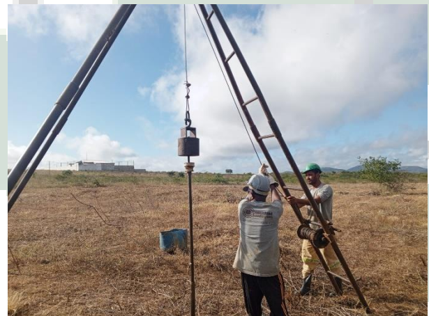
Foto 12 EXECUÇÃO DE SONDAGEM À PERCUSSÃO (SPT).
