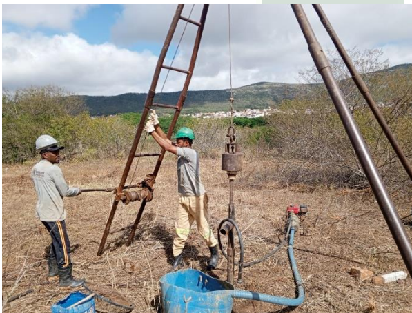
Foto 11 EXECUÇÃO DE SONDAGEM À PERCUSSÃO (SPT).
