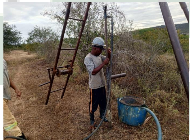
Foto 18 EXECUÇÃO DE SONDAÇÃO À PERCUSSÃO (SPT).
