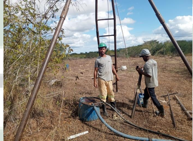
Foto 08 EXECUÇÃO DE SONDAGEM À PERCUSSÃO (SPT).
