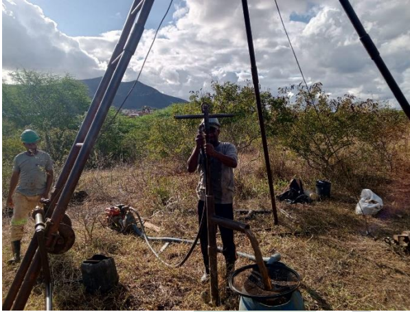
Foto 13 EXECUÇÃO DE SONDAÇÃO À PERCUSSÃO (SPT).
