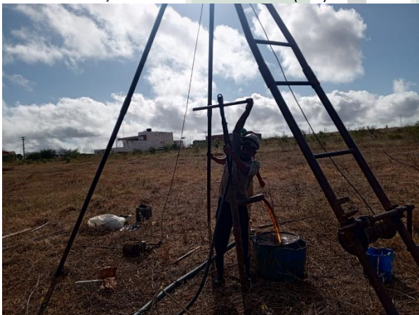
Foto 03 EXECUÇÃO DE SONDAGEM À PERCUSSÃO (SPT).
