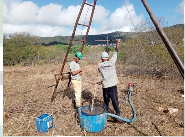
Foto 14 EXECUÇÃO DE SONDAÇÃO À PERCUSSÃO (SPT).
