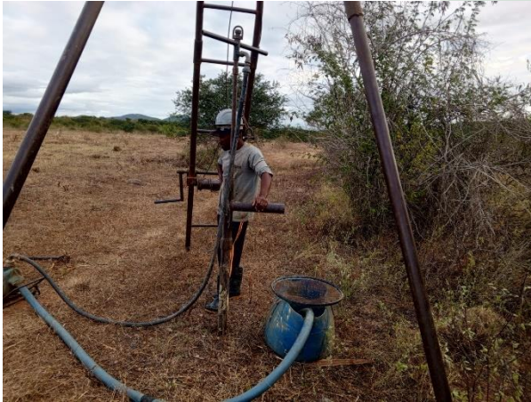
Foto 01 EXECUÇÃO DE SONDAGEM À PERCUSSÃO (SPT).
