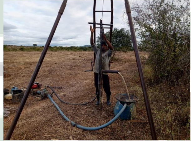
Foto 02 EXECUÇÃO DE SONDAGEM À PERCUSSÃO (SPT).
