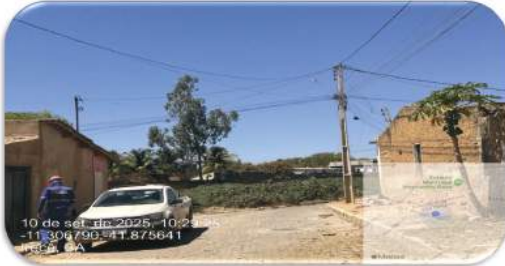
Imagem 11 - Estaca 10 Descrição: Situação atual da Rua/Avenida.
