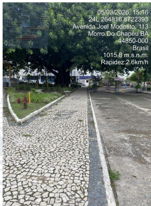
Fig. 02: Final do trecho de intervenção.
