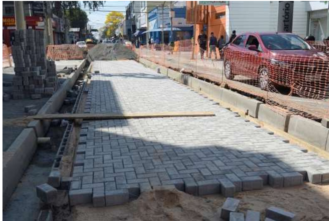
Imagem 02: Intertravado sendo assentado verificando o alinhamento, nivelamento e arremates.
