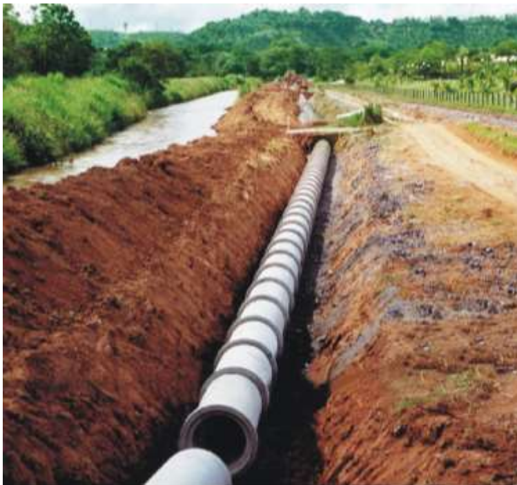
Imagem 03: Tubo de concreto sendo assentado verificando o alinhamento, queda e rejunte.
