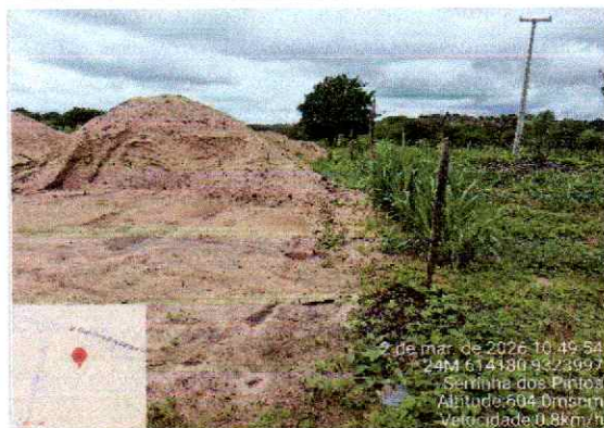
FOTO P1 SENTIDO SUL -6.114756, -37.968191
