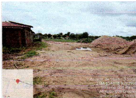
FOTO P1 SENTIDO LESTE -6.114756, -37.968191
