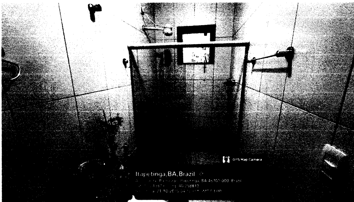
Imagem 35: Banheiro 1º Andar
