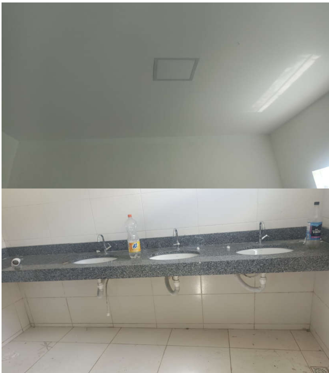
Foto 33 e 34: Vista atual do vestiário da quadra.
