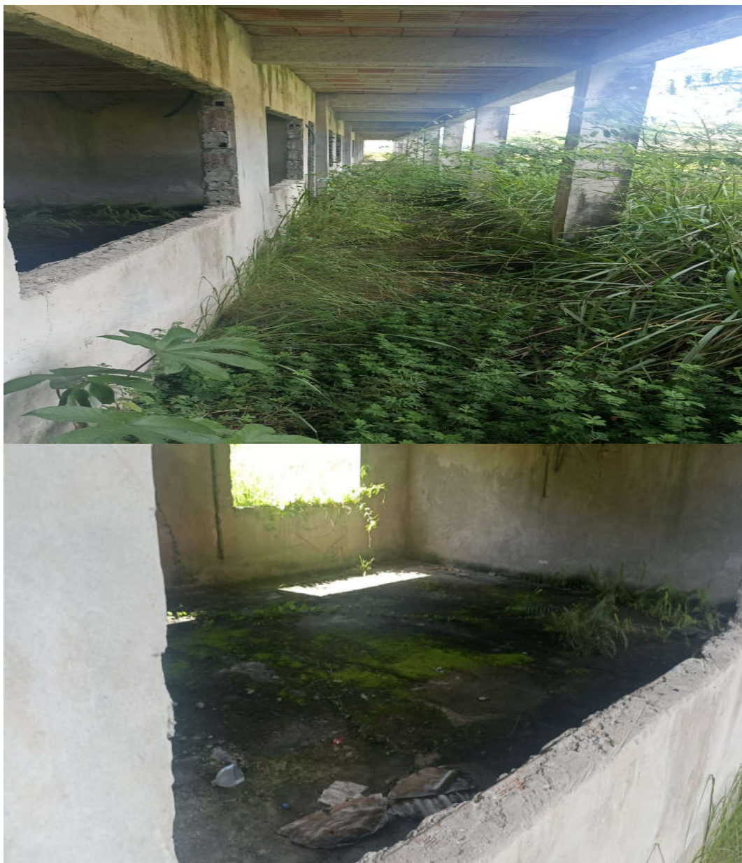
Foto 25 e 26: Vista atual do local da escola..
