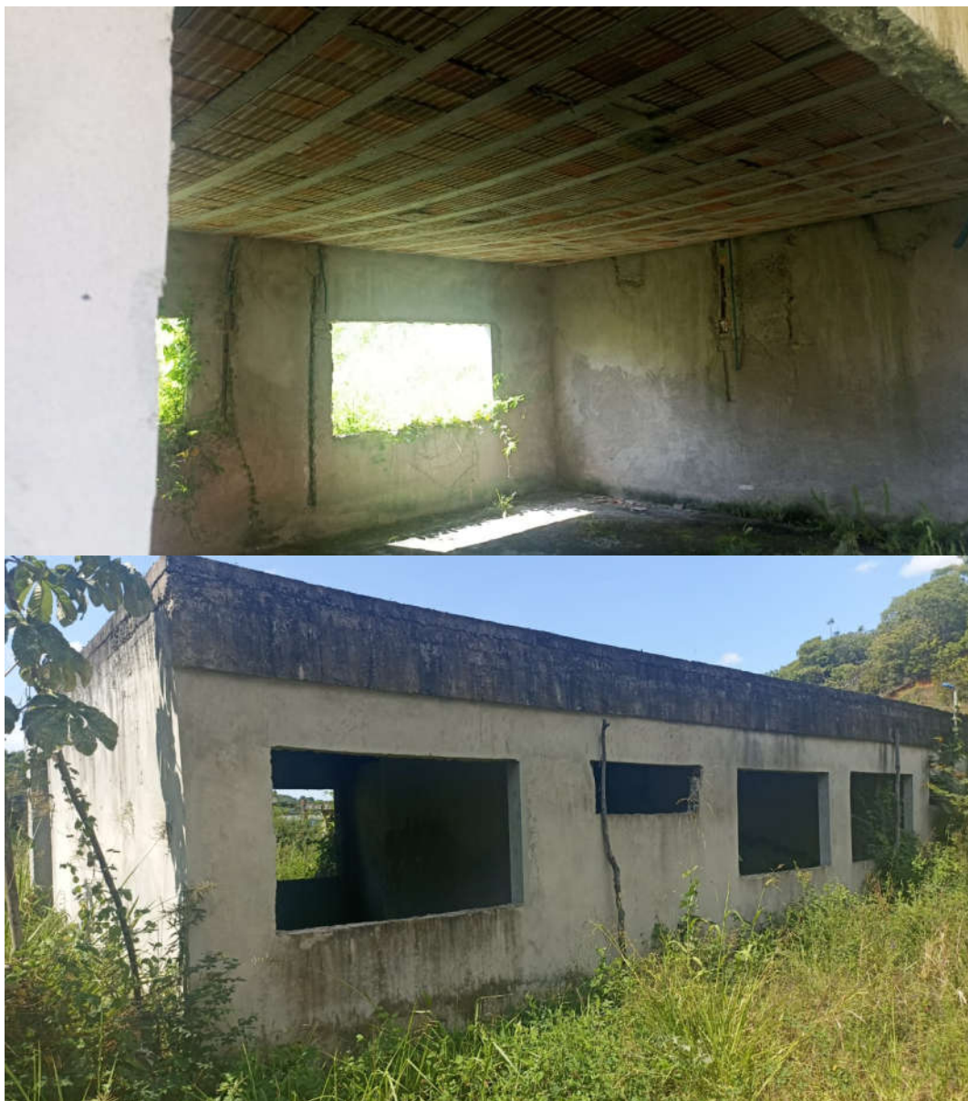
Foto 27 e 28: Vista atual do local da escola..
