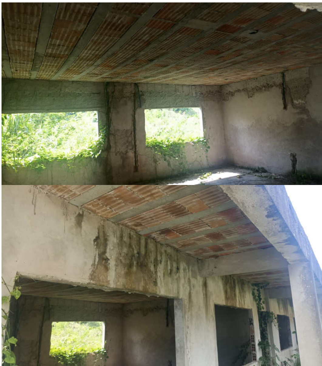
Foto 31 e 32: Vista atual do local da escola..
