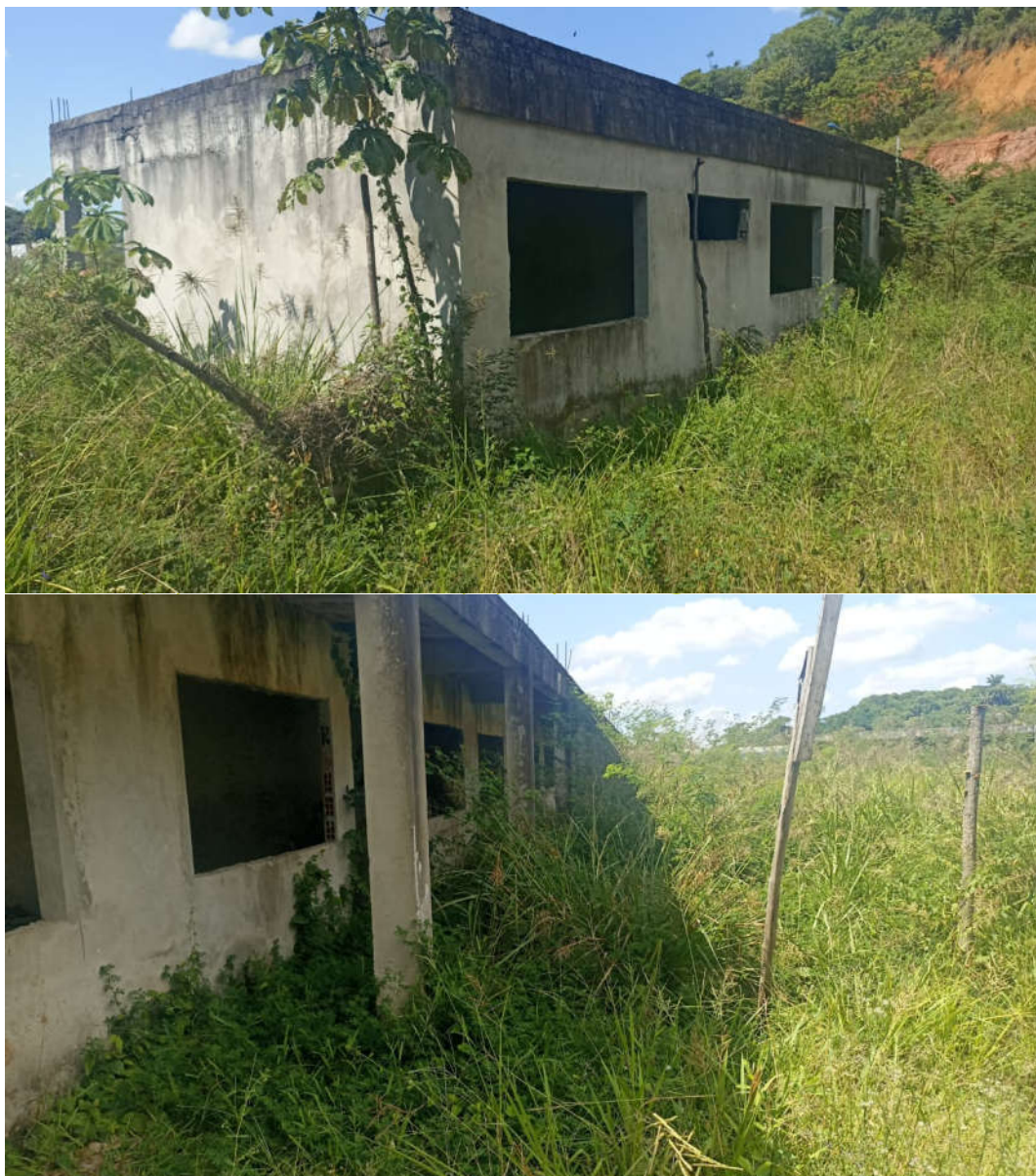
Foto 29 e 30: Vista atual do local da escola..
