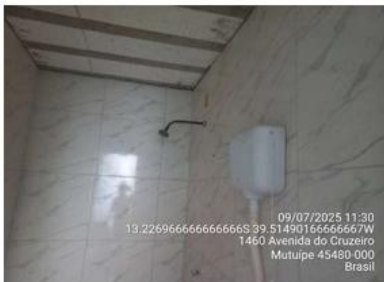
Imagem 6 – Vista interna banheiro existente na Área de Intervenção.
