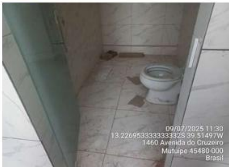
Imagem 5 – Vista interna banheiro existente na Área de Intervenção.
