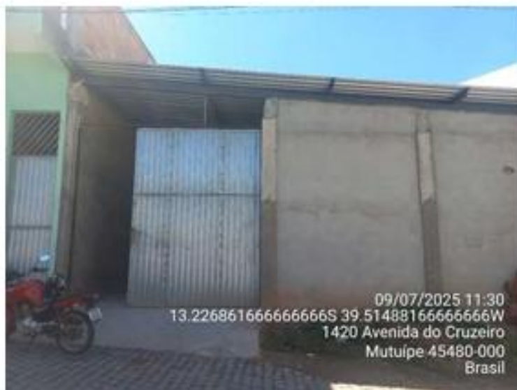
Imagem 1 – Vista frontal do acesso à Área de intervenção.
