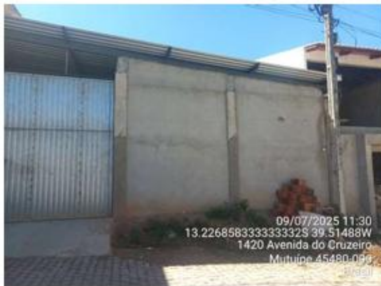
Imagem 2 – Vista frontal do acesso à Área de Intervenção.
