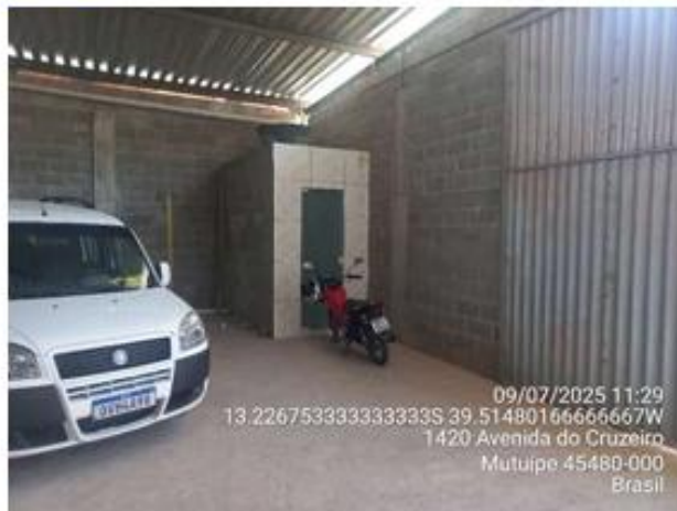
Imagem 7 – Vista interna da Área de intervenção.
