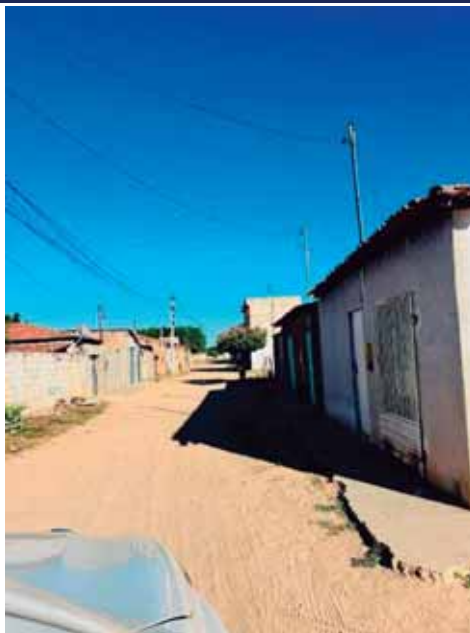
Foto 07: Situação do trecho que será pavimentado.
