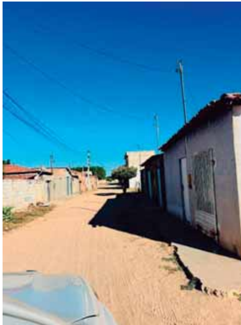
Foto 06: Situação do trecho que será pavimentado.
