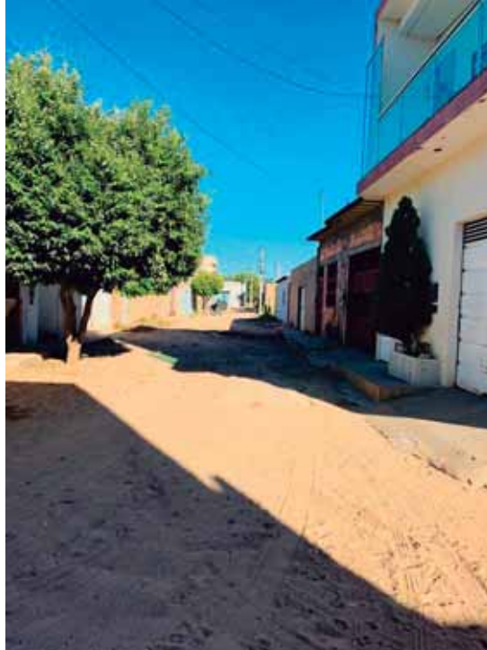
Foto 08: Situação do trecho que será pavimentado.
