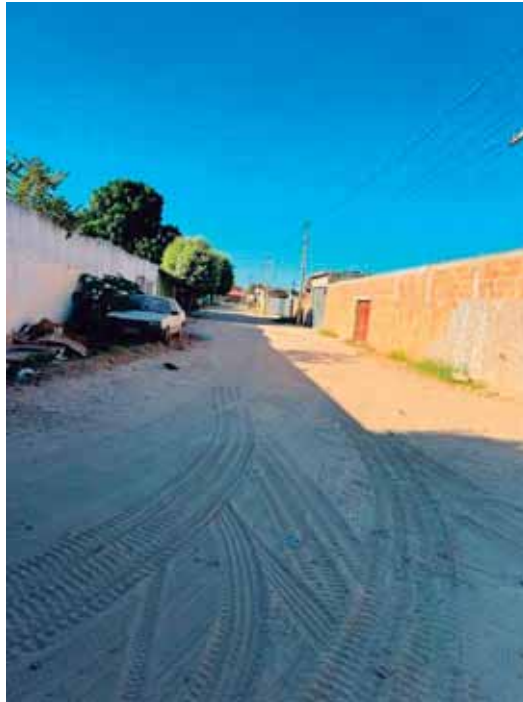
Foto 03: Situação do trecho que será pavimentado.
