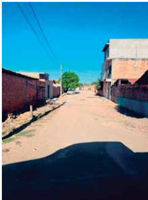
Foto 09: Situação do trecho que será pavimentado.
