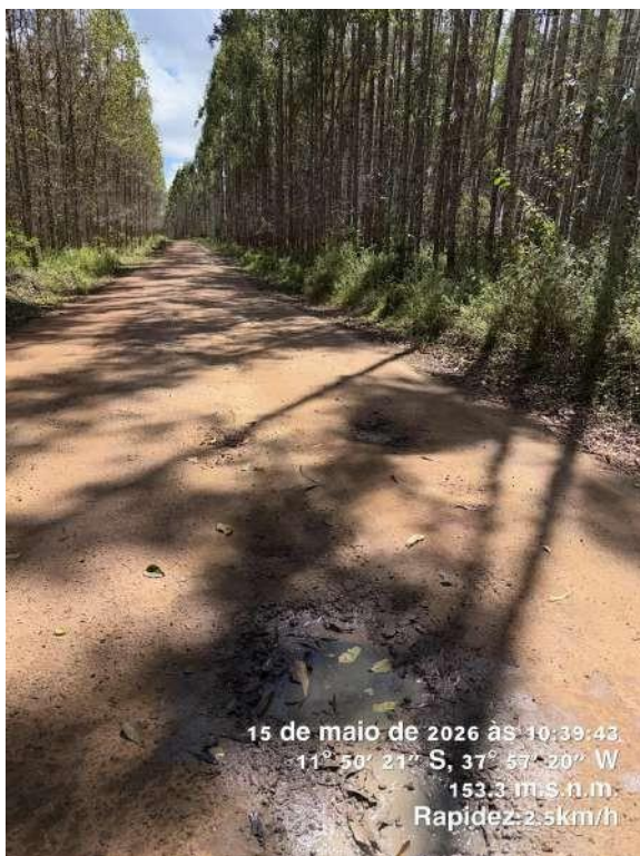
Foto A: Situação da estrada que sofrerá intervenção
