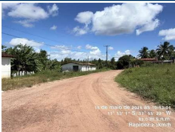
Foto A: Situação da estrada que sofrerá intervenção
