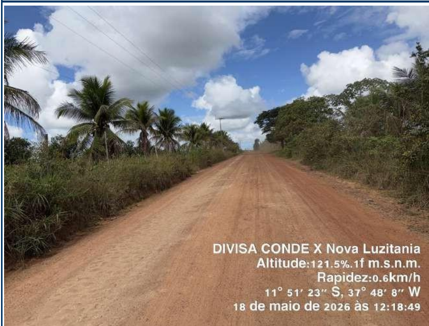
Foto A: Situação da estrada que sofrerá intervenção
