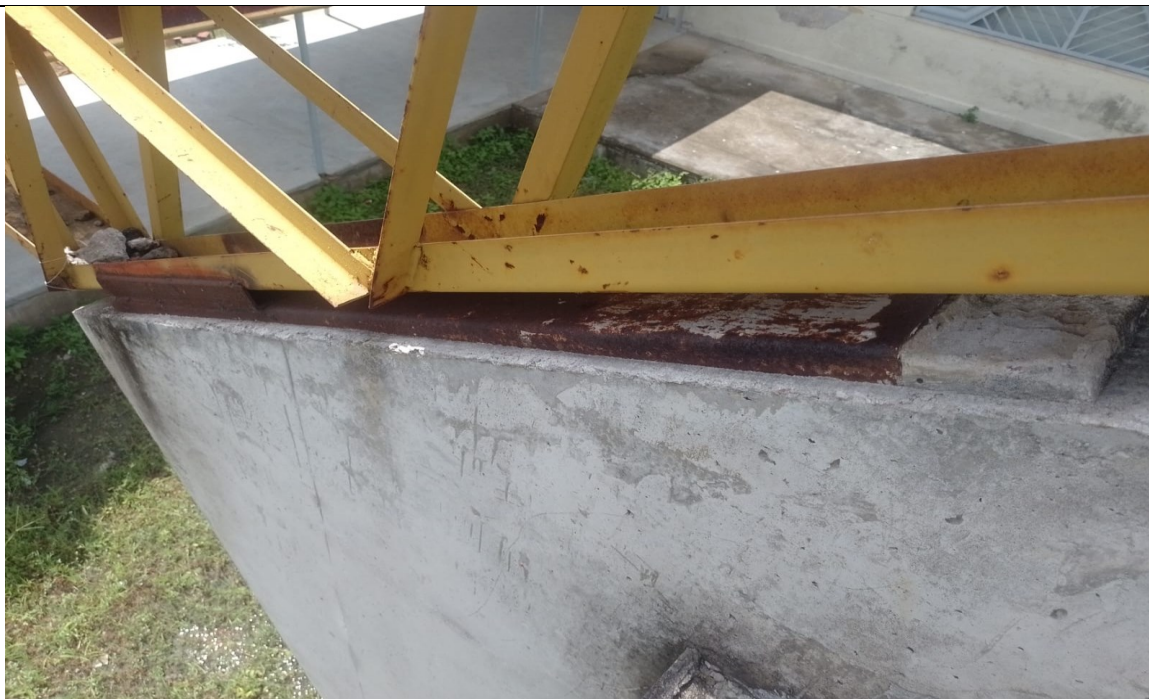
Figura 45 – Chapa de base entre a tesoura e o pilar em concreto
