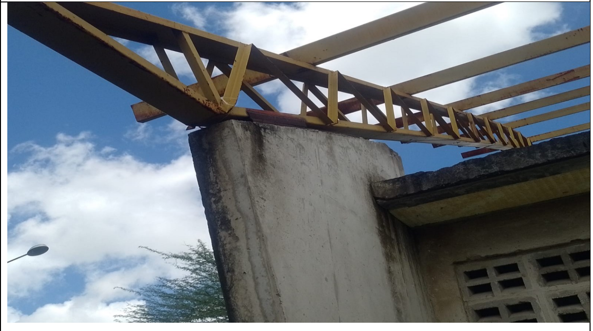
Figura 46 – Chapa de base entre a tesoura e o pilar em concreto
