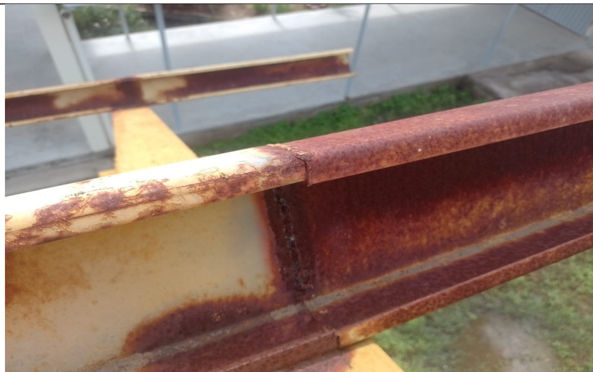
Figura 50 – Abertura nas soldas
