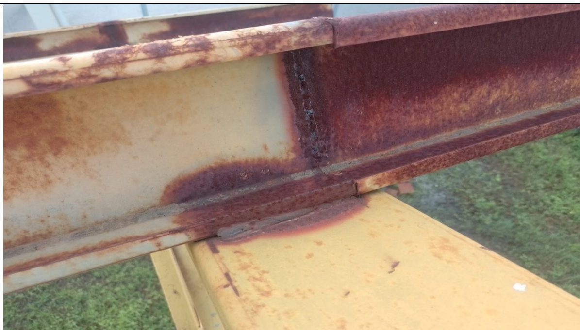
Figura 52 – Solda das terças sem tratamento
