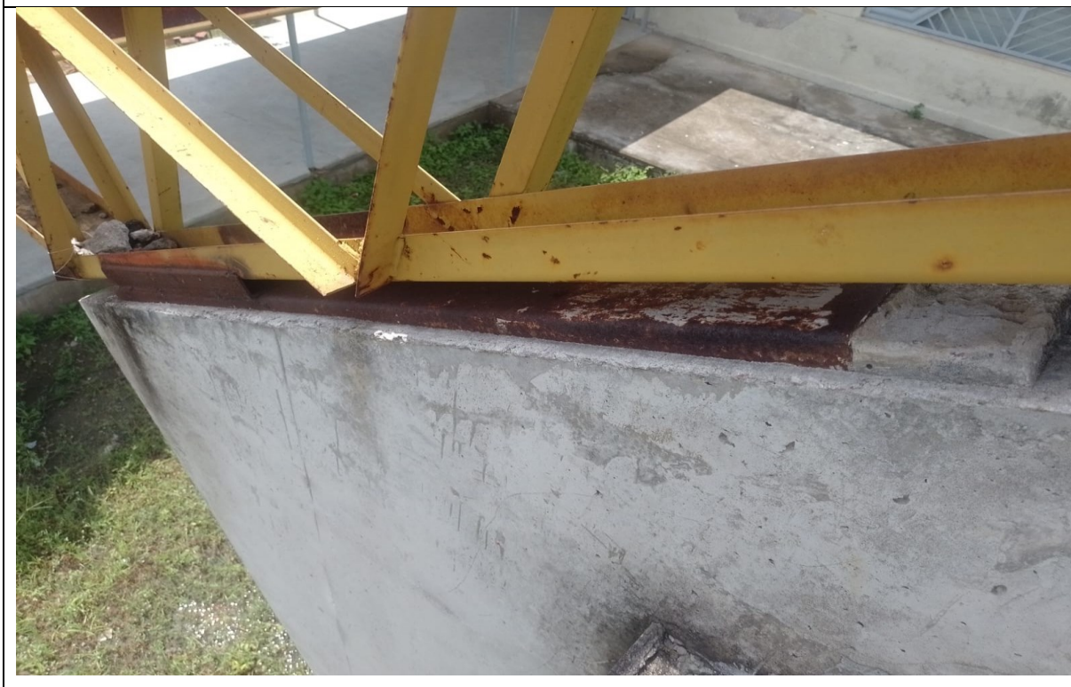
Figura 51 – Chapa de base entre a tesoura e o pilar em concreto
