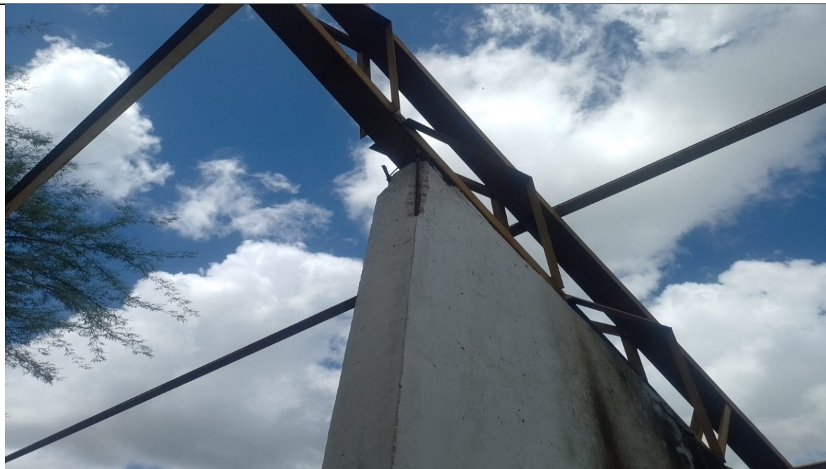
Figura 47 – Ferragem dos pilares expostas
