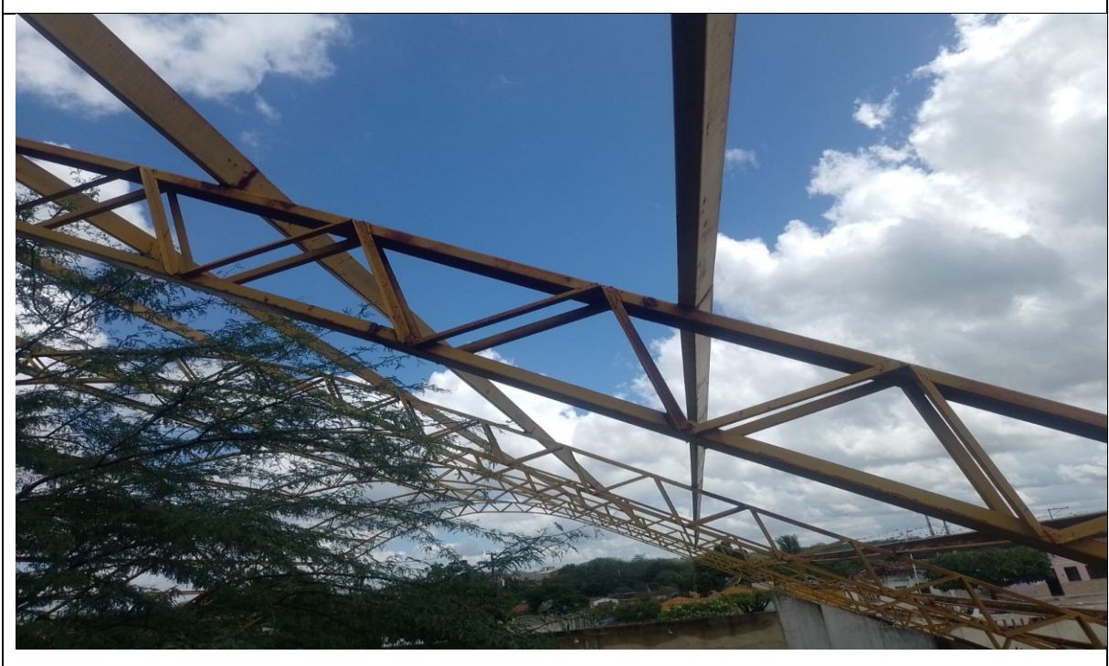
Figura 48 – Manchas de corrosão na estrutura
