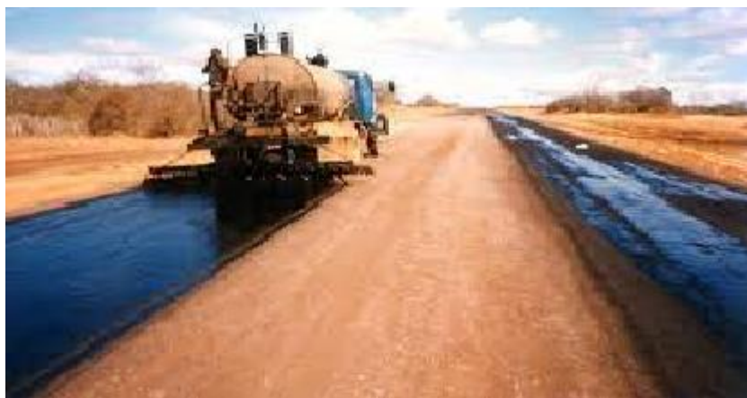
Imagem: Imprimação asfáltica
