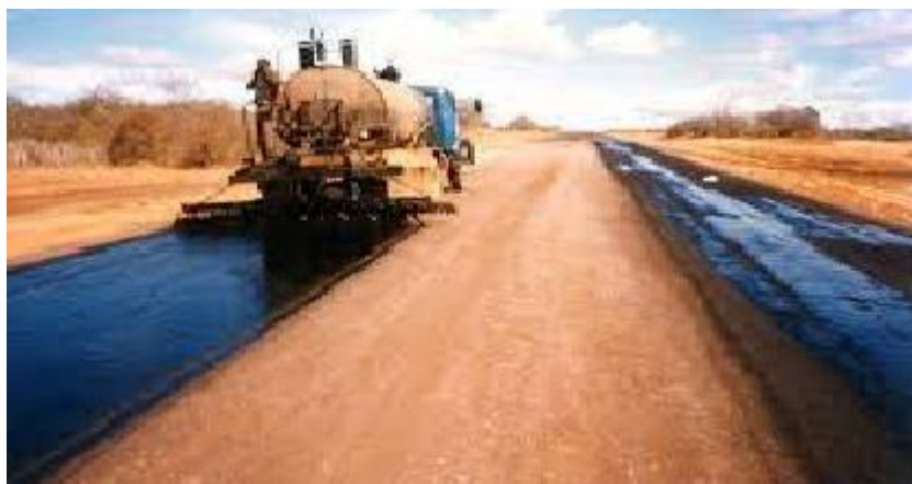
Imagem: Imprimação asfáltica
