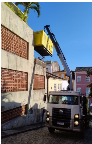
Foto 7: Locação com Munk
