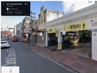
Foto 14: Entrada do Estacionamento
