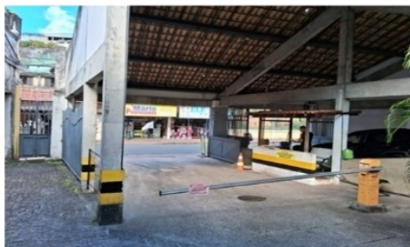
Foto 13: Local do posicionamento dos geradores
