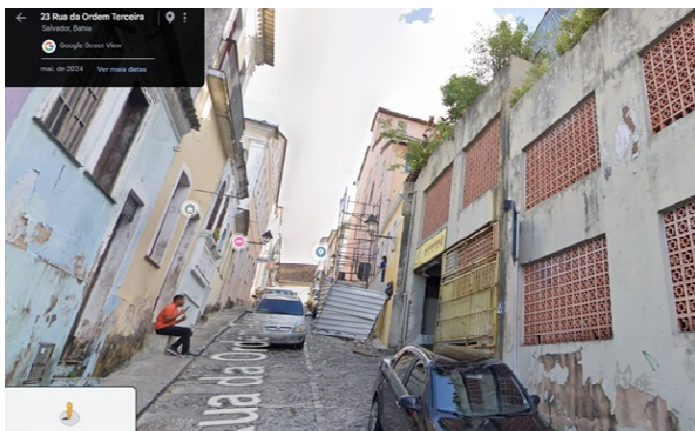
Foto 3: Entrada do estacionamento do Largo Pedro Archanjo
