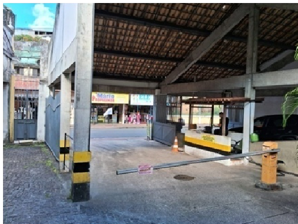
Foto 8: Local do posicionamento do gerador.
