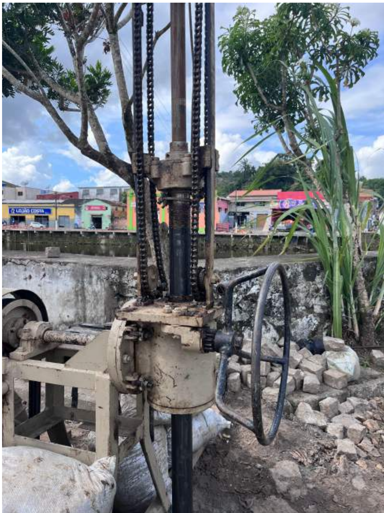
Figura 12 – Execução do SM03 (autoria própria, 2025)
