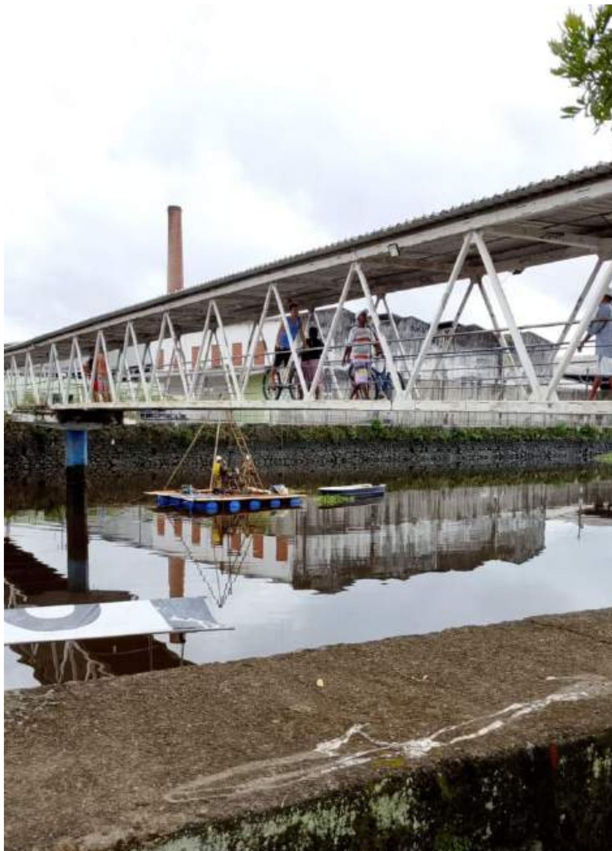
Figura 7 – Execução do SM02 (autoria própria, 2025)
