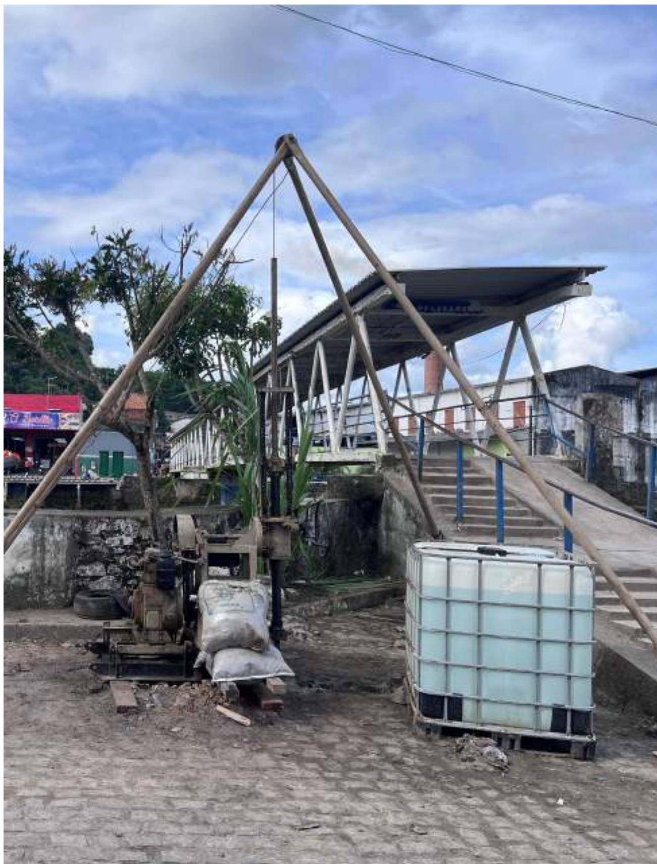
Figura 2 –Execução do SM01 (autoria própria, 2025)
