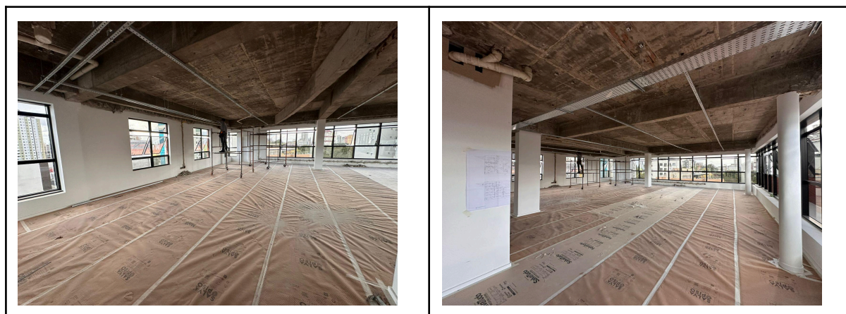
Figura 2. Espaço destinado para a instalação da sala do CSDP.
