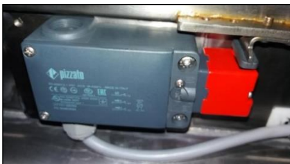
Proteções móveis com chaves de segurança magnéticas com retenção
