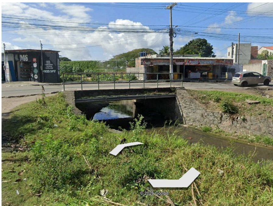
Figura 1 – Pontilhão existente na Rua A
