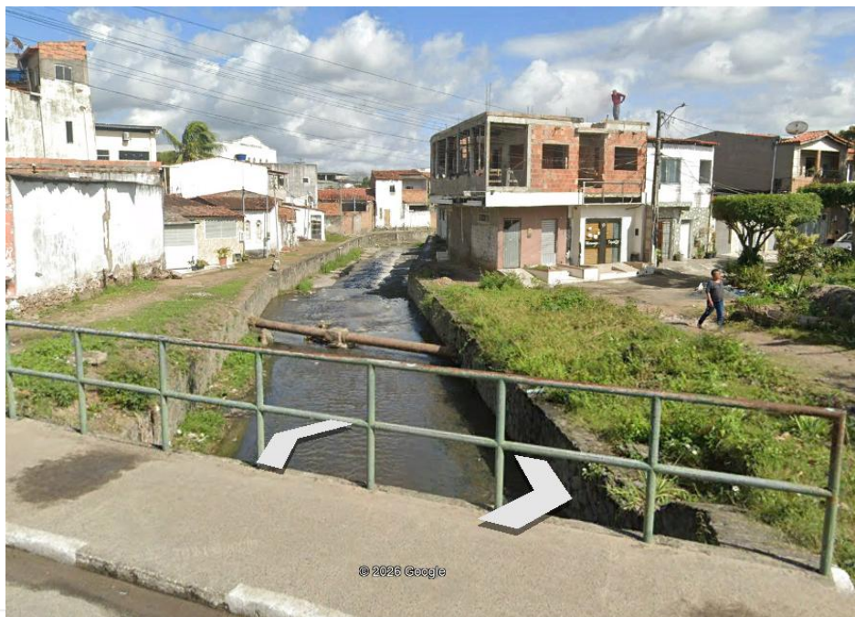
Figura 2 – Canal de jusante do pontilhão existente na Rua A
