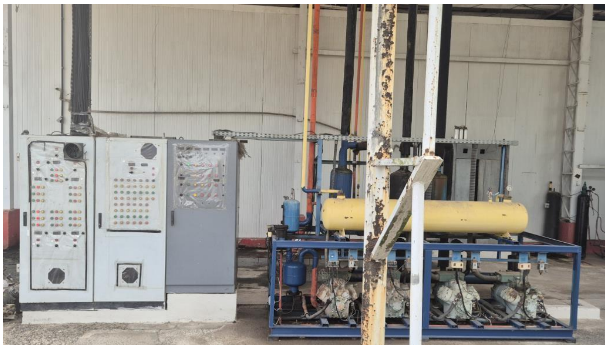
Foto 7: Sistema de frio de câmara fria
