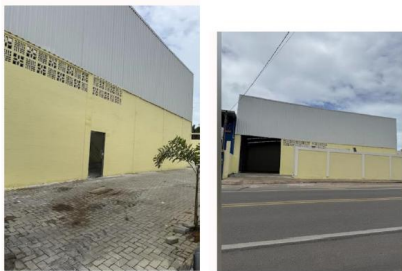
Fachada do galpão, vista da Avenida das Conchas
