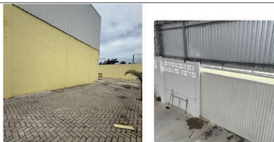
Área externa pavimentada e portão de acesso
