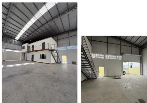
Vista interna do galpão, com mezanino
