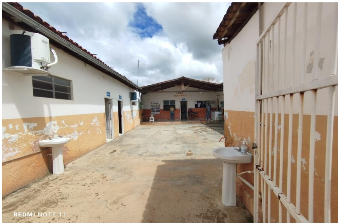
FOTO 11: PISO DE CONCRETO
