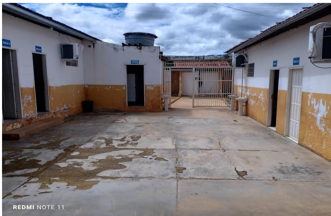
FOTO 12: PISO DE CONCRETO
