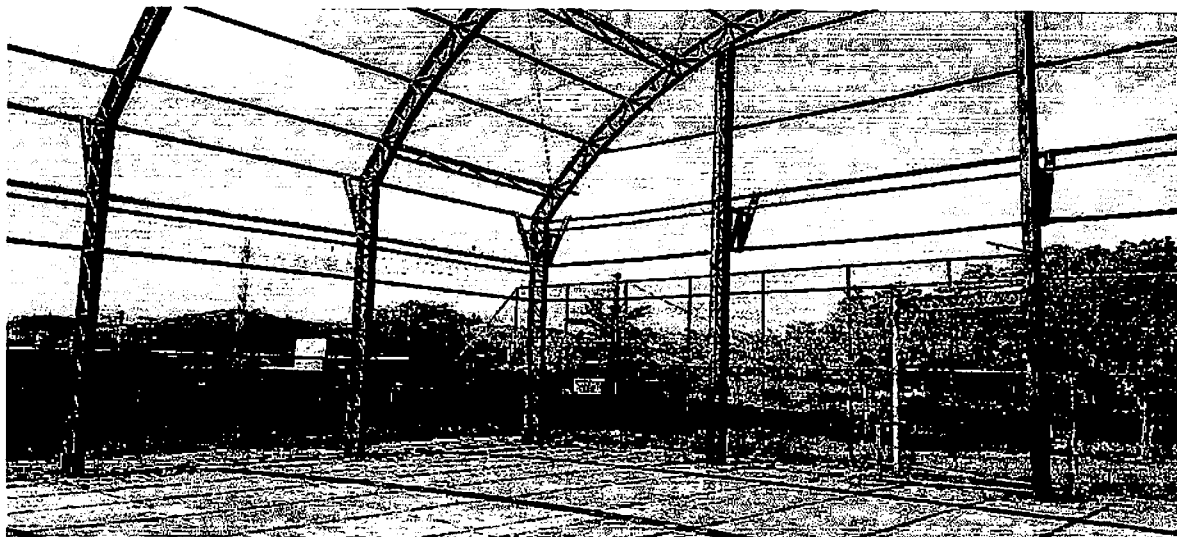
Figura 19 - Vista Estrutura Metálica
