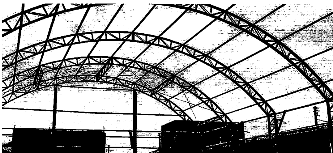
Figura 12 - Vista da estrutura metálica
