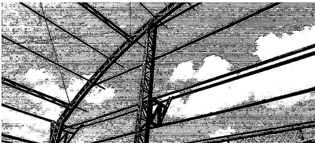
Figura 13 - Vista da Estrutura
