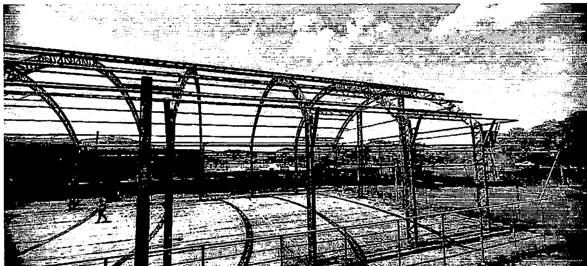
Figura 15 - Vista da Estrutura
