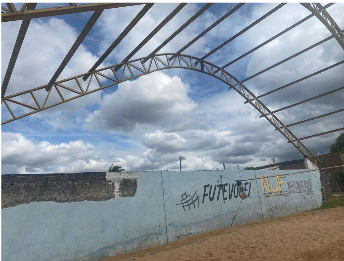
Figura 4 – Parede com reboco deficiente devido a infiltração de água de chuva
