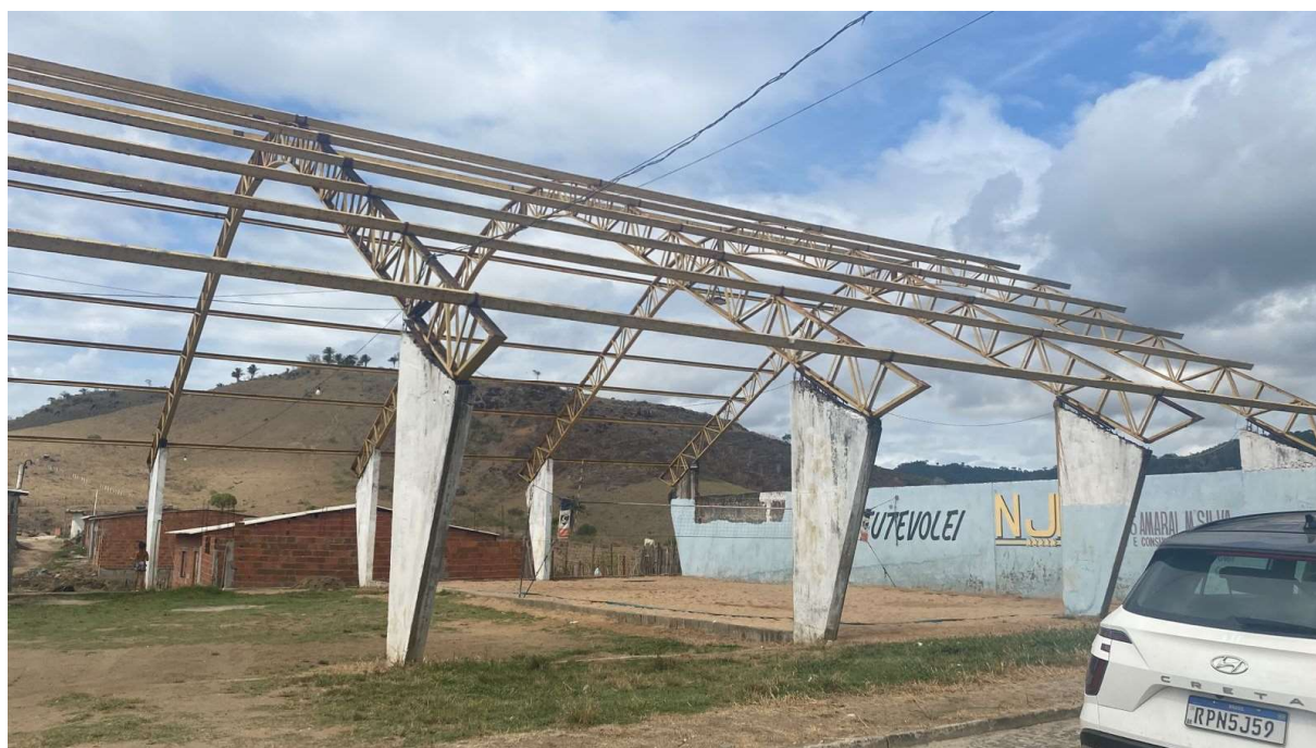
Figura 24 – Vista da Obra
