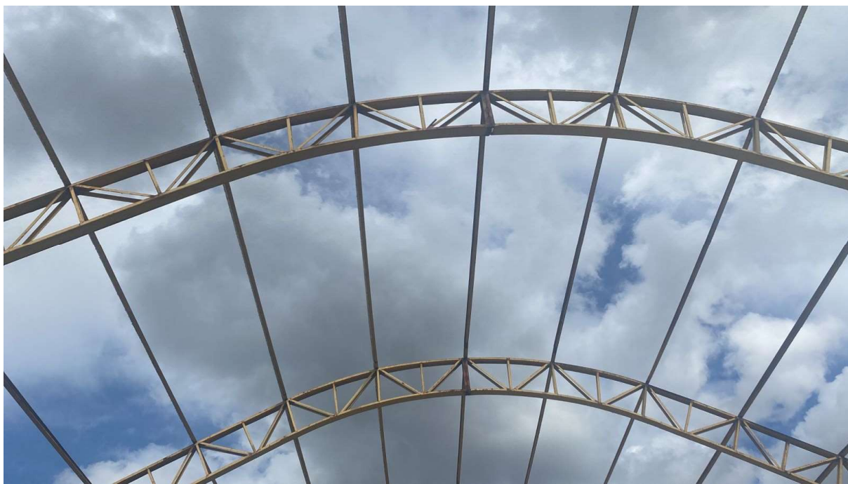
Figura 22 – Vista da Estrutura Metálica
