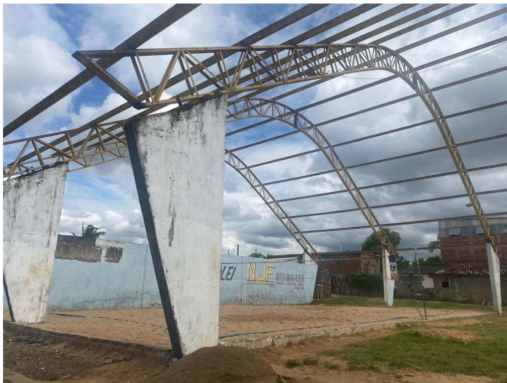
Figura 6 - Vista da estrutura
