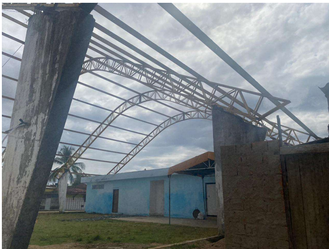
Figura 10 – Vista da Estrutura
