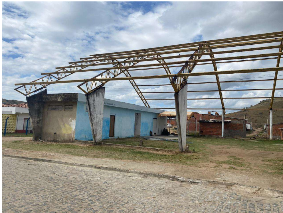
Figura 17 - Vista da Estrutura
