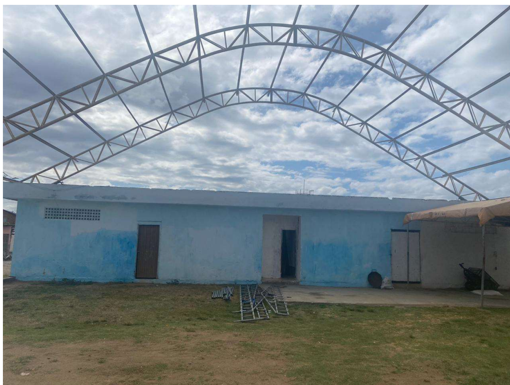
Figura 12 - Vista da Vestiário
