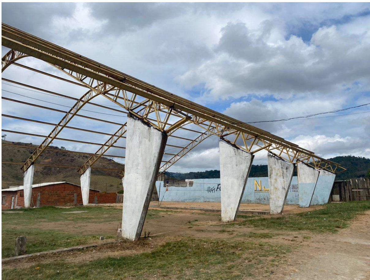
Figura 18 - Vista Estrutura Metálica
