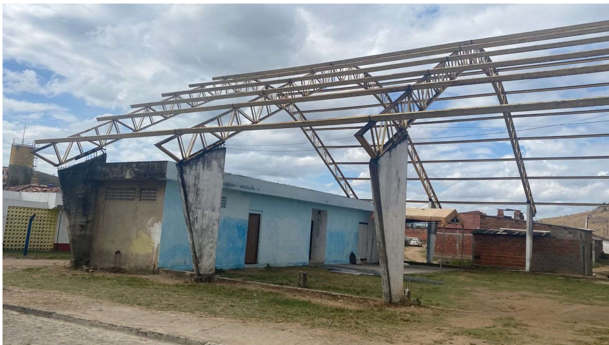
Figura 2 - Vista frontal da obra
