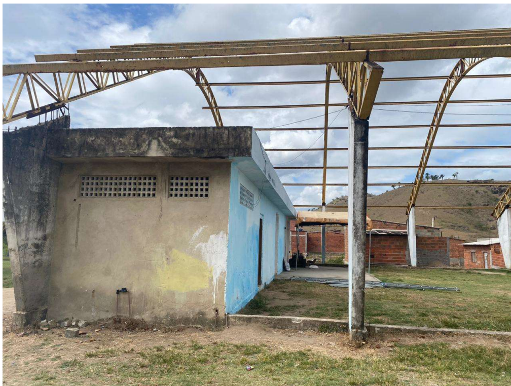
Figura 15 - Vista Lateral do vestiário
