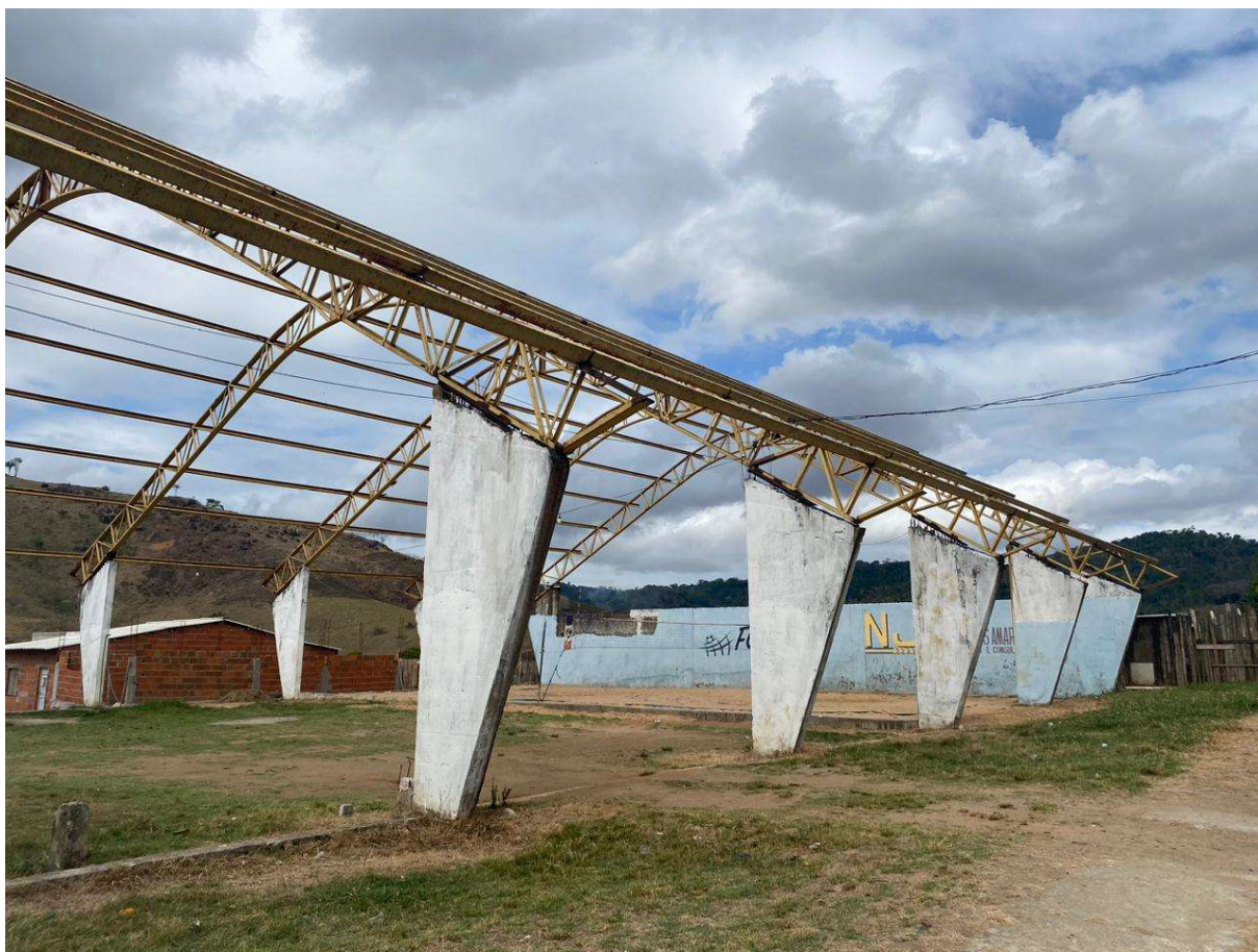
Figura 3 - Vista da estrutura metálica
