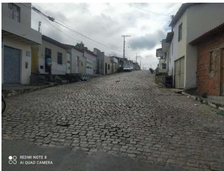
Foto 11 - Vista de ponto crucial que recebe a água pluvial de todas as regiões, vista em direção da Rua Antero Duarte.
