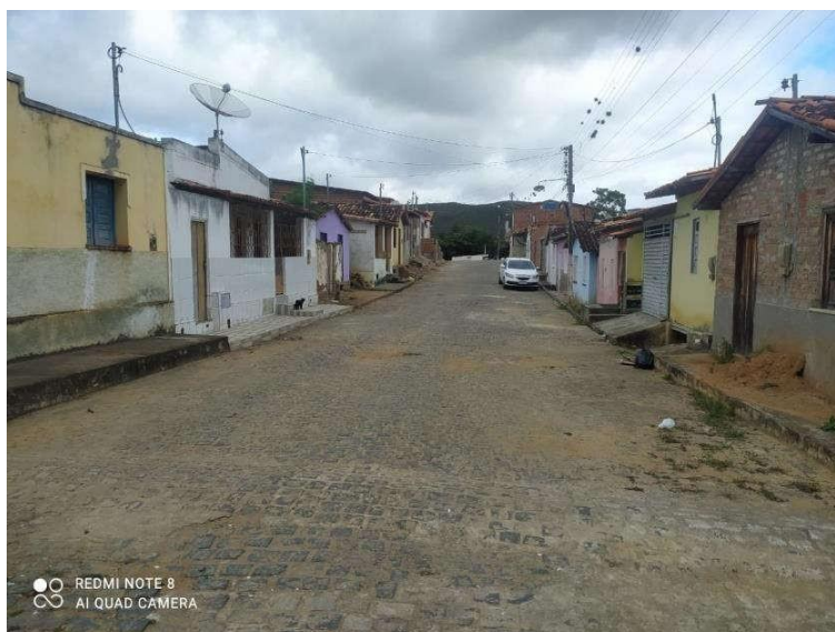
Foto 4 - Vista a partir do ponto de entrada na Rua Eduardo Teles para Rua Antero Duarte.
