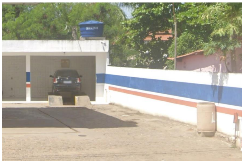
Foto 17 – Vista do muro do posto à ser demolido e reconstruído (Praça Dr. Juvenal Montanha/Posto de Combustível) em sentido a ligação final de desague da drenagem.
