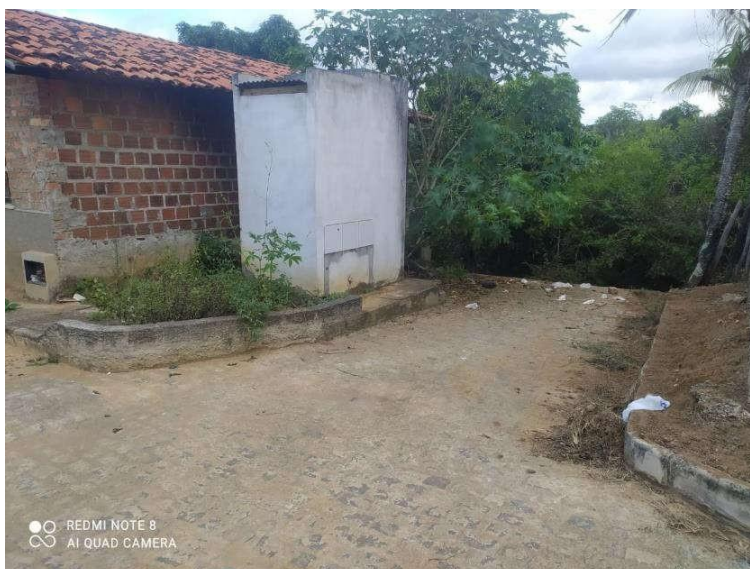
Foto 2 - Ponto de entrada de águas pluviais na Rua Eduardo Teles que recebe da Região 1.
