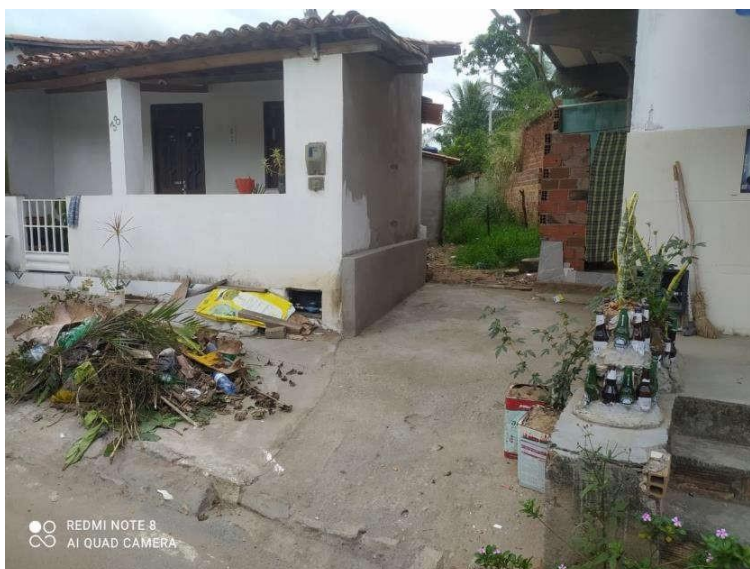
Foto 7 - Ponto de saída das águas pluviais na Rua Antônio Emílio dos Reis da região demonstrada em mapa como região 1.
