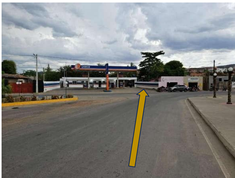
Foto 15 – Vista em ponto frente a rodoviária (Praça Dr. Juvenal Montanha) em sentido a ligação final de deságue da drenagem.
