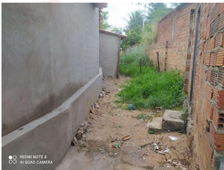
Foto 8 - Imagem aproximada de ponto de saída de águas pluviais na Rua Antônio Emílio dos Reis da Região 1.
