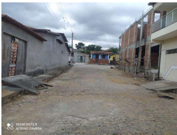
Foto 5 - Vista do ponto de entrada na Rua Eduardo Teles da Região 1, para a Rua Nélío Gomes.
