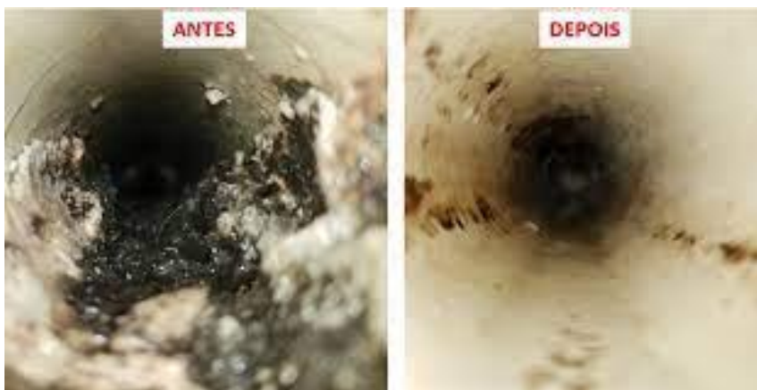
Imagem 03 - APLICAÇÃO DE PRODUTO QUÍMICO "DESINCRUSTANTE" EM POÇO 2.4 MÃO DE OBRA PARA LIGAR, DESLIGAR (MOTORES E BOMBAS) E SERVIÇOS CORRELACIONADOS
