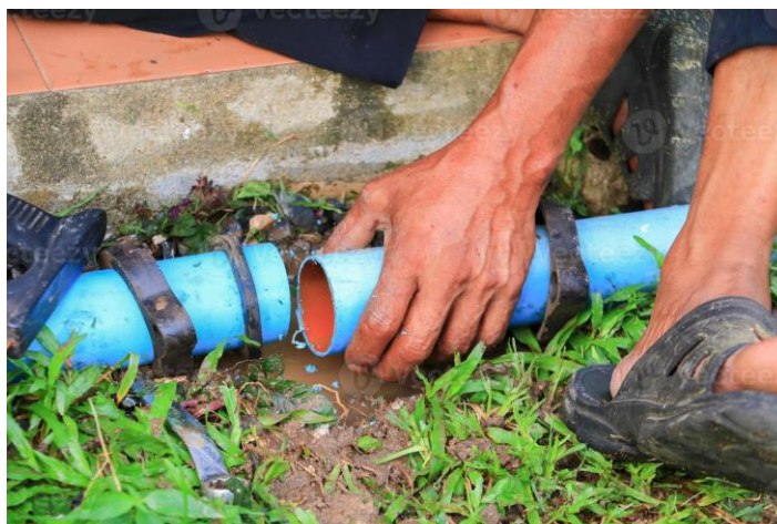
Imagem 01 - REVISÃO DE PONTO DE ÁGUA TIPO 2
