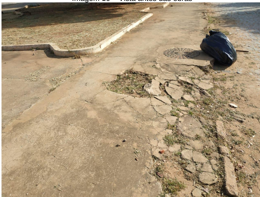
Imagem 11 – Vista antes das obras
