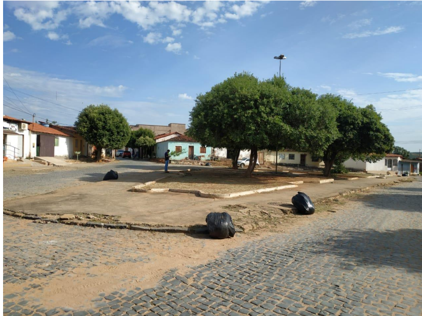
Imagem 08 – Vista antes das obras
