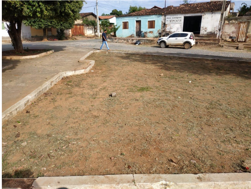
Imagem 06 – Vista antes das obras
