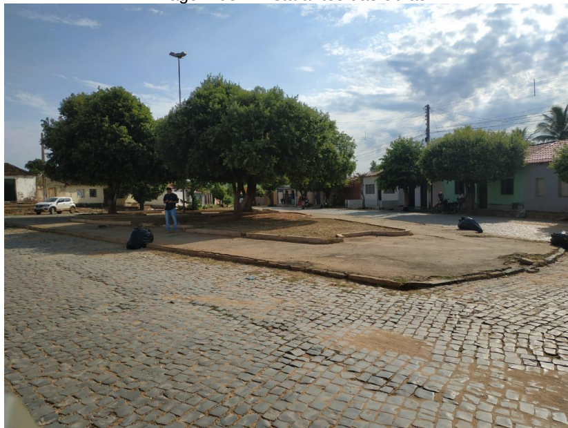
Imagem 09 – Vista antes das obras
