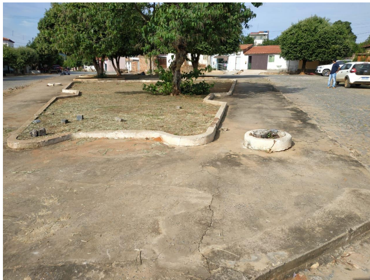
Imagem 01 – Vista antes das obras
