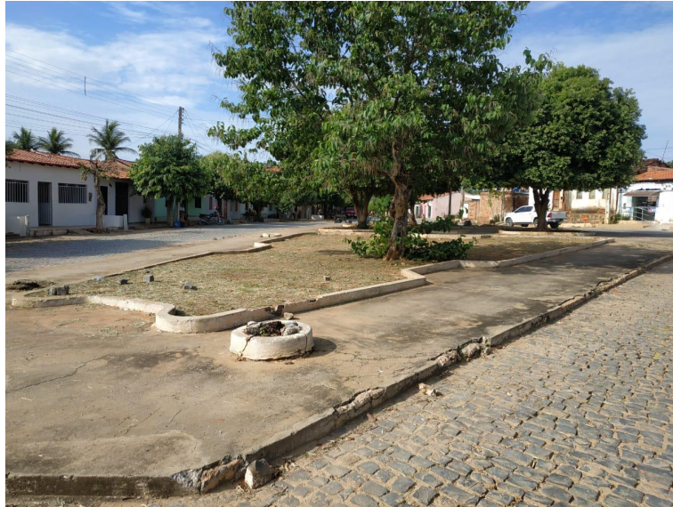
Imagem 02 – Vista antes das obras
