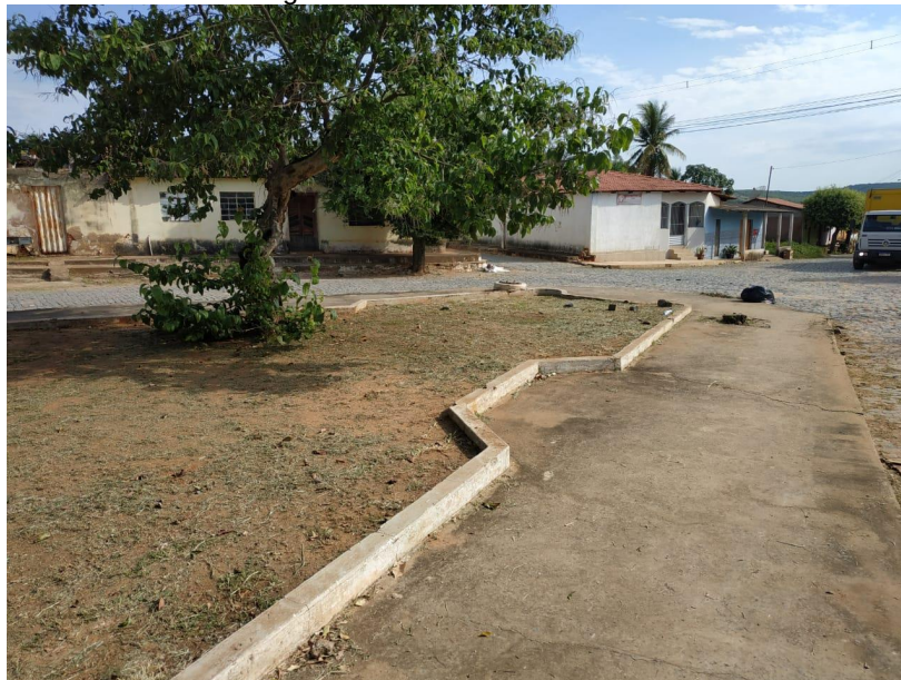
Imagem 03 – Vista antes das obras
