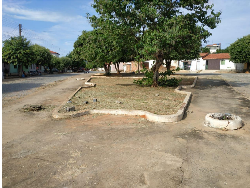
Imagem 04 – Vista antes das obras
