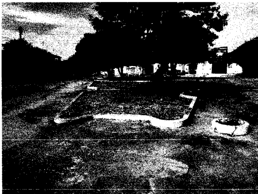
Imagem 04 – Vista antes das obras
