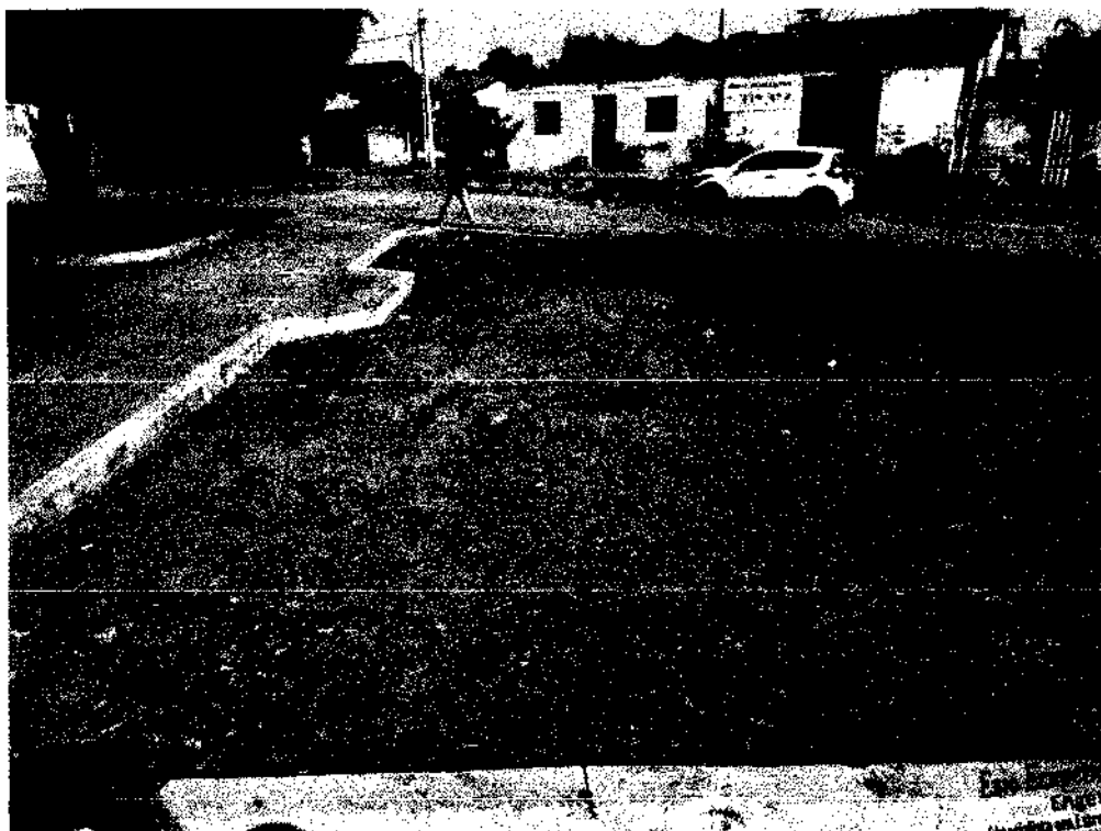
Imagem 06 – Vista antes das obras
