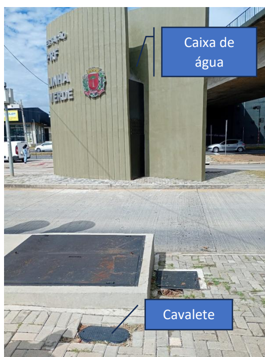
Figura 1: Localização dos elementos de ligação do banheiro
