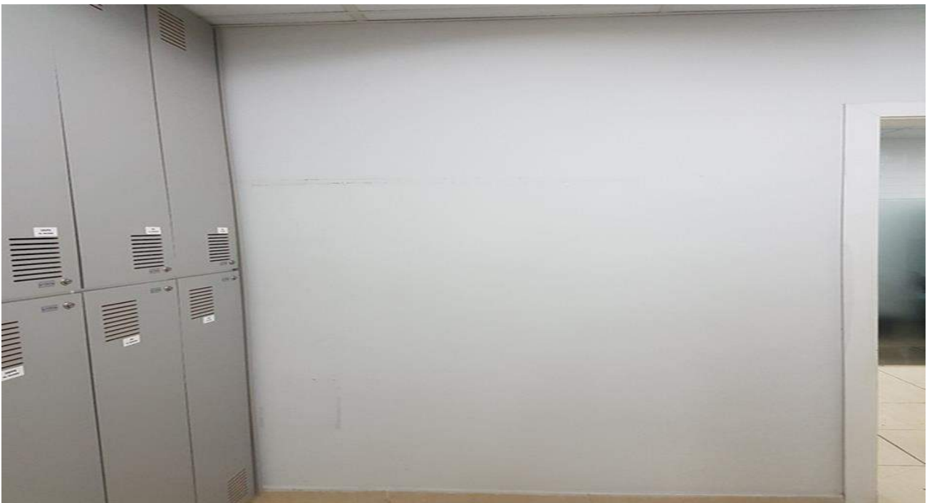
Imagem 43 - Localização: Banheiro Masculino
