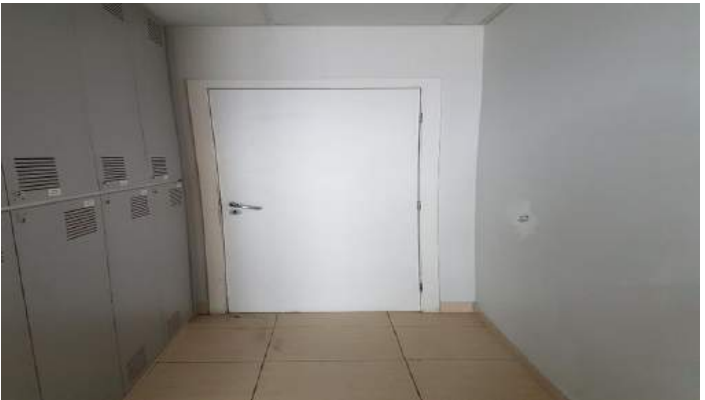
Imagem 37 - Localização: Sala de descompressão (DSIPS)
