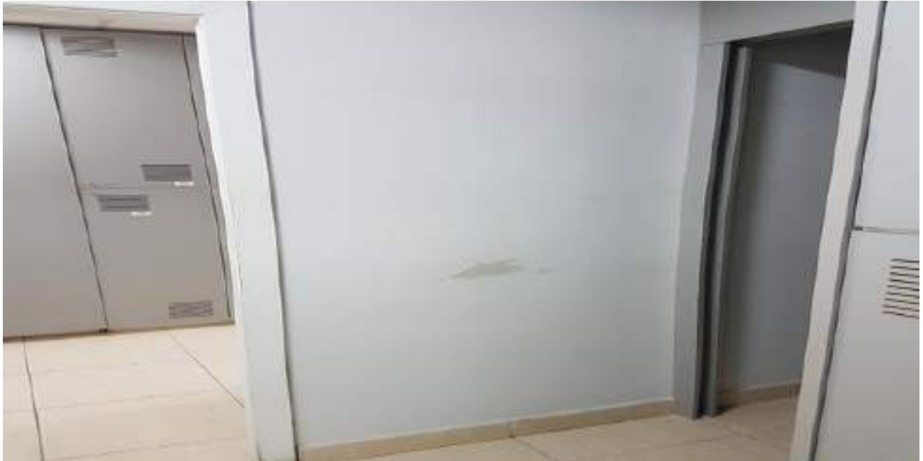
Imagem 44 - Localização: Banheiro Masculino
