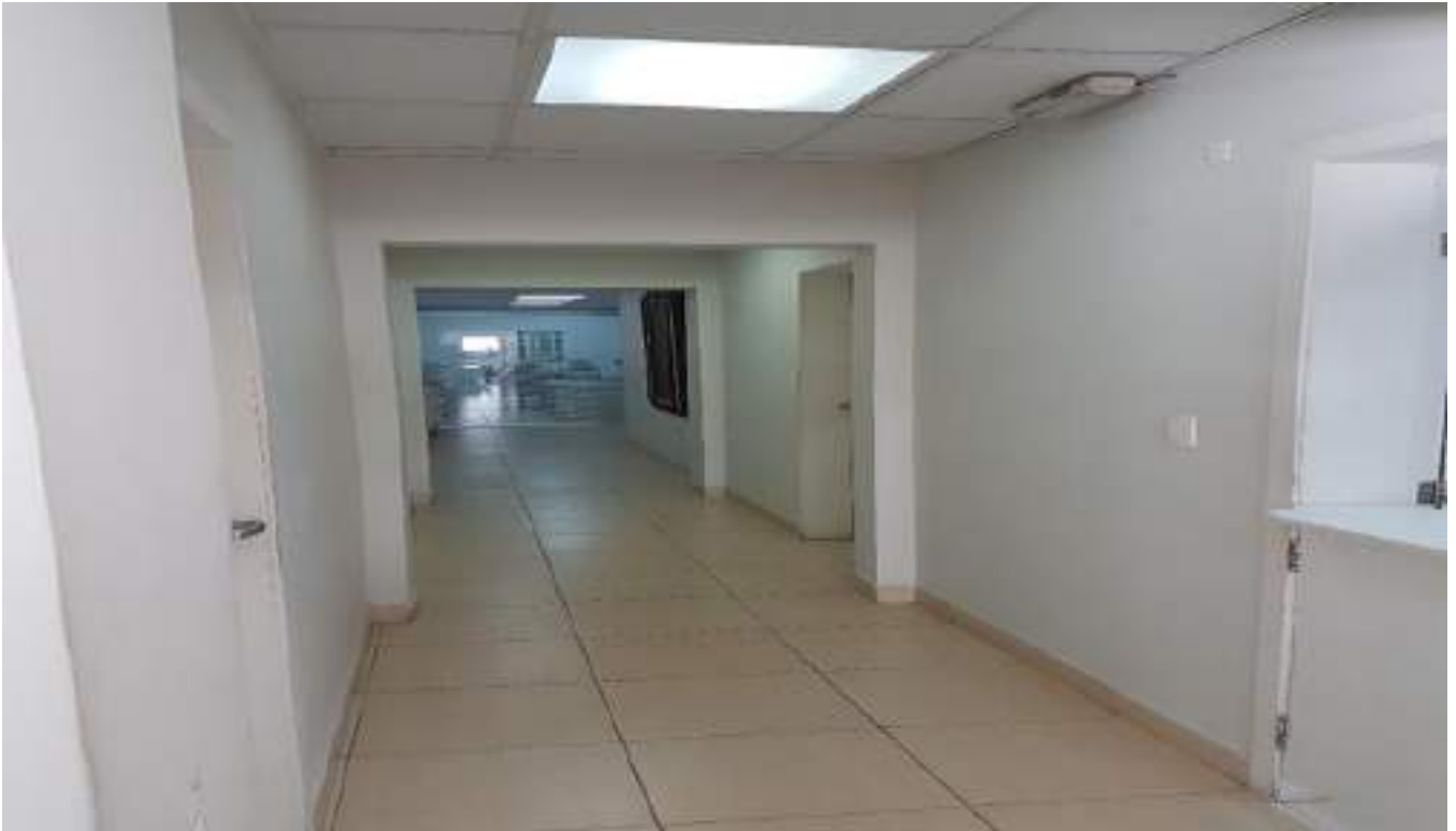
Imagem 24 – Localização: Corredores do Prédio Anexo A
