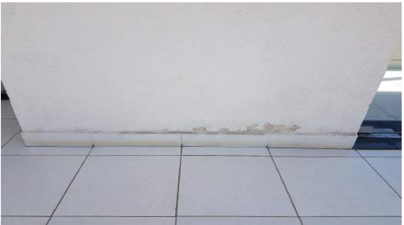
Imagem 16 - Localização: Parede lateral do Prédio Anexo A
