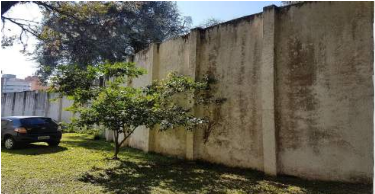
Imagem 18 - Localização: Muro lateral do Prédio Anexo A
