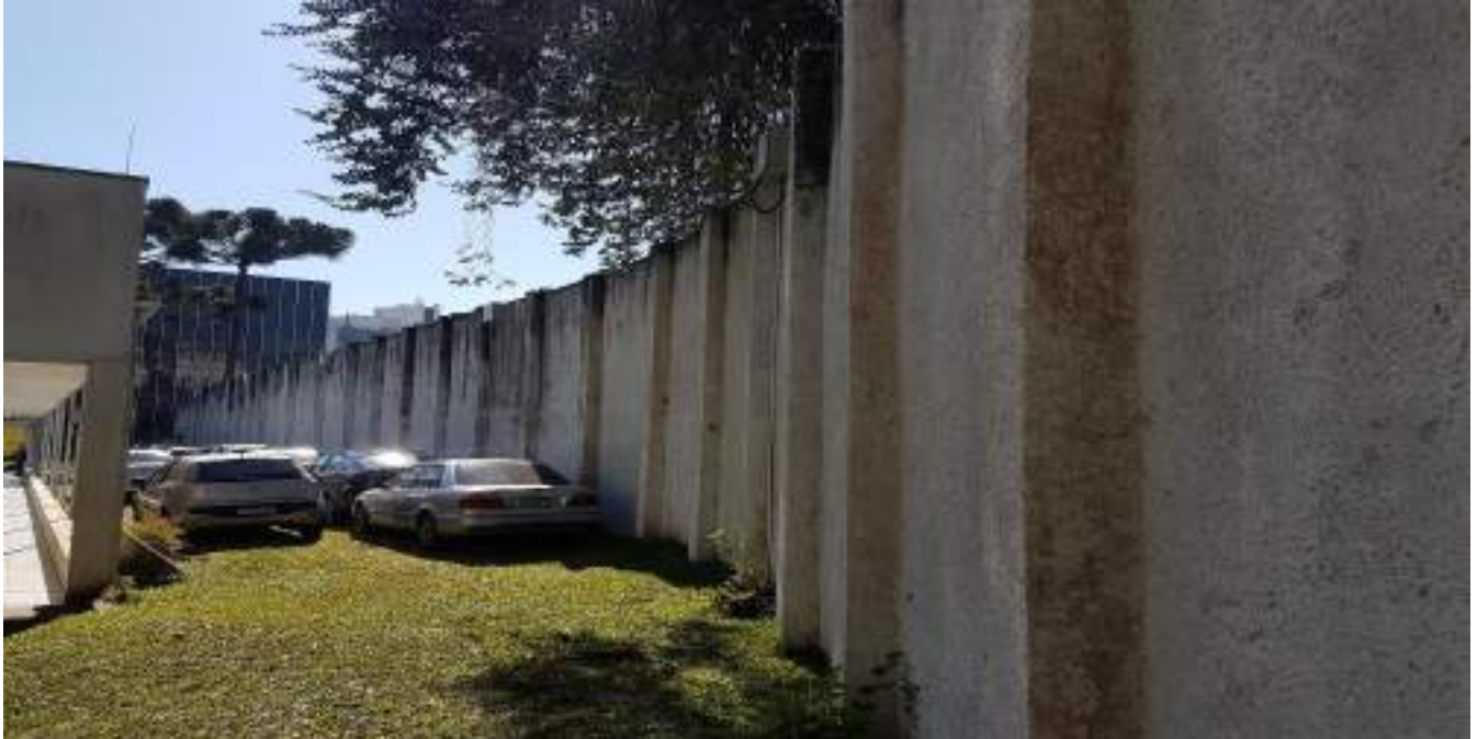
Imagem 19 - Localização: Muro lateral do Prédio Anexo A
