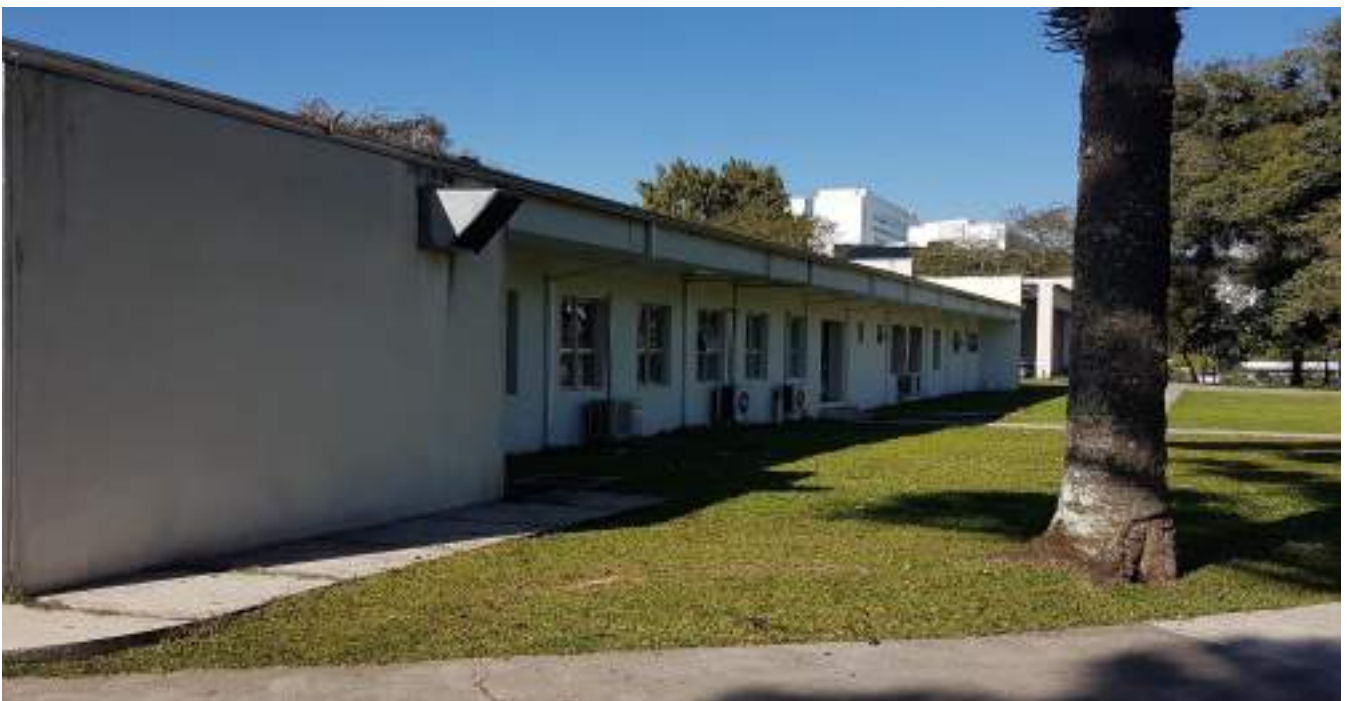
Imagem 4 - Localização: Lateral central do Prédio Anexo A.
