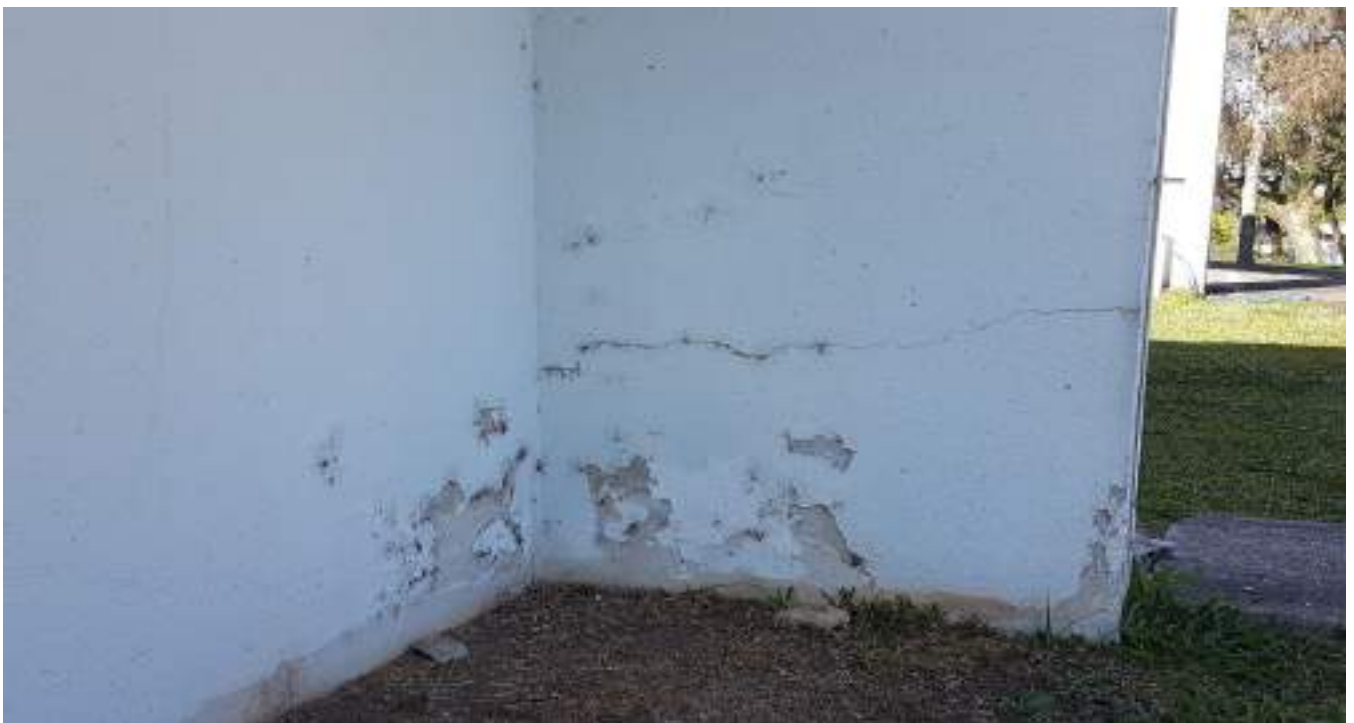
Imagem 8 - Localização: Parede lateral central do Prédio Anexo A
