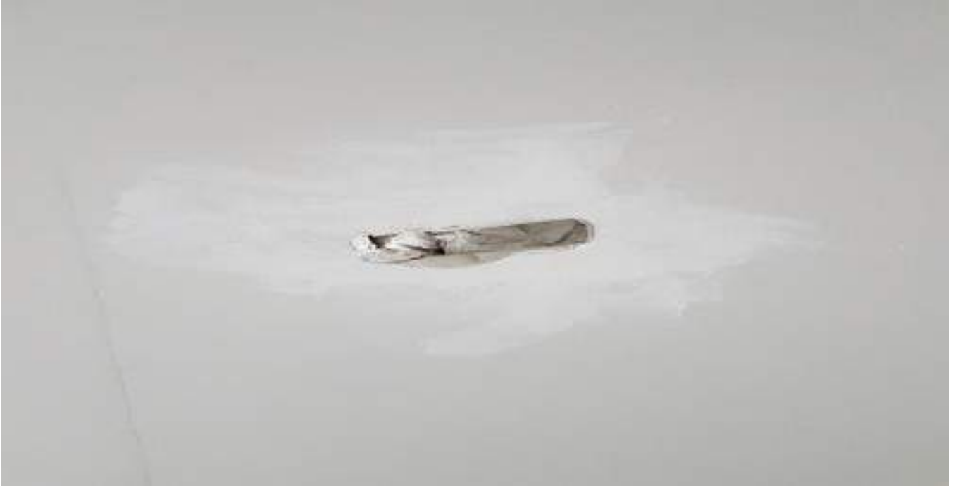
Imagem 38 - Localização: Sala de descompressão (DSIPS)
