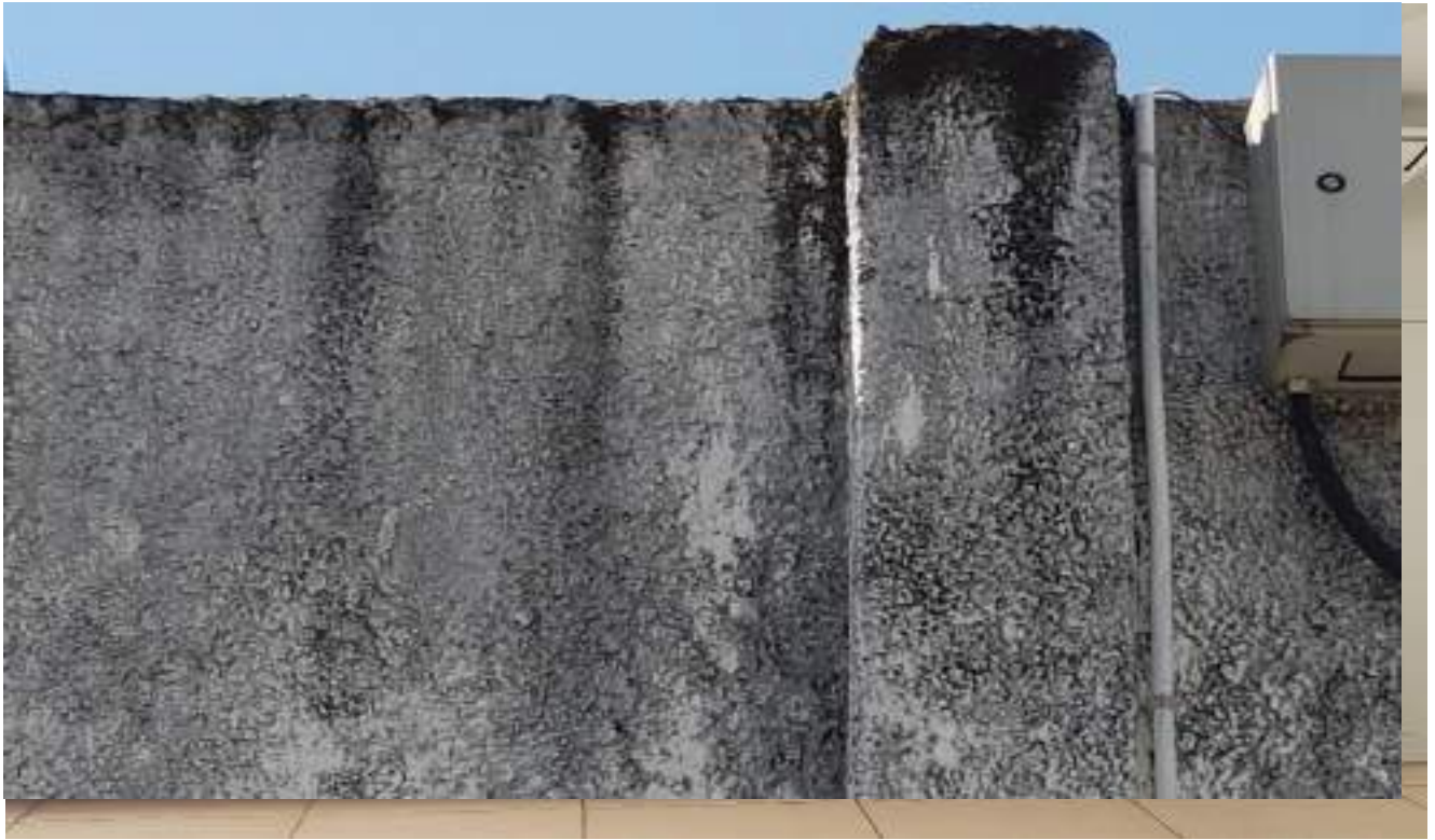
Imagem 21 - Localização: Muro lateral do Prédio Anexo A
