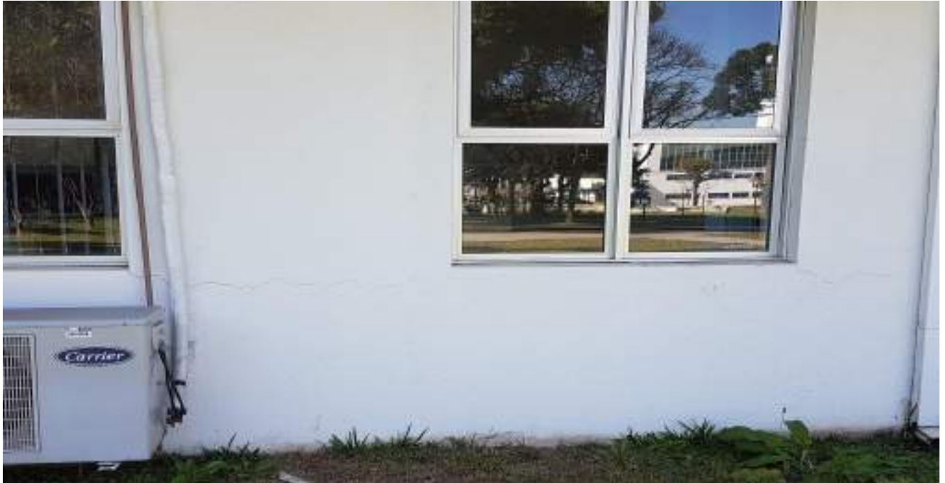
Imagem 7 - Localização: Parede lateral central do Prédio Anexo A
