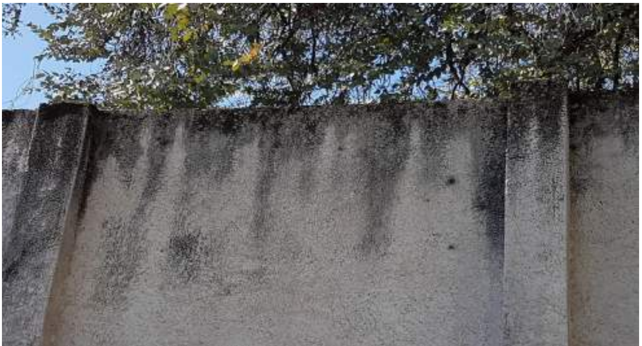
Imagem 20 - Localização: Muro lateral do Prédio Anexo A
