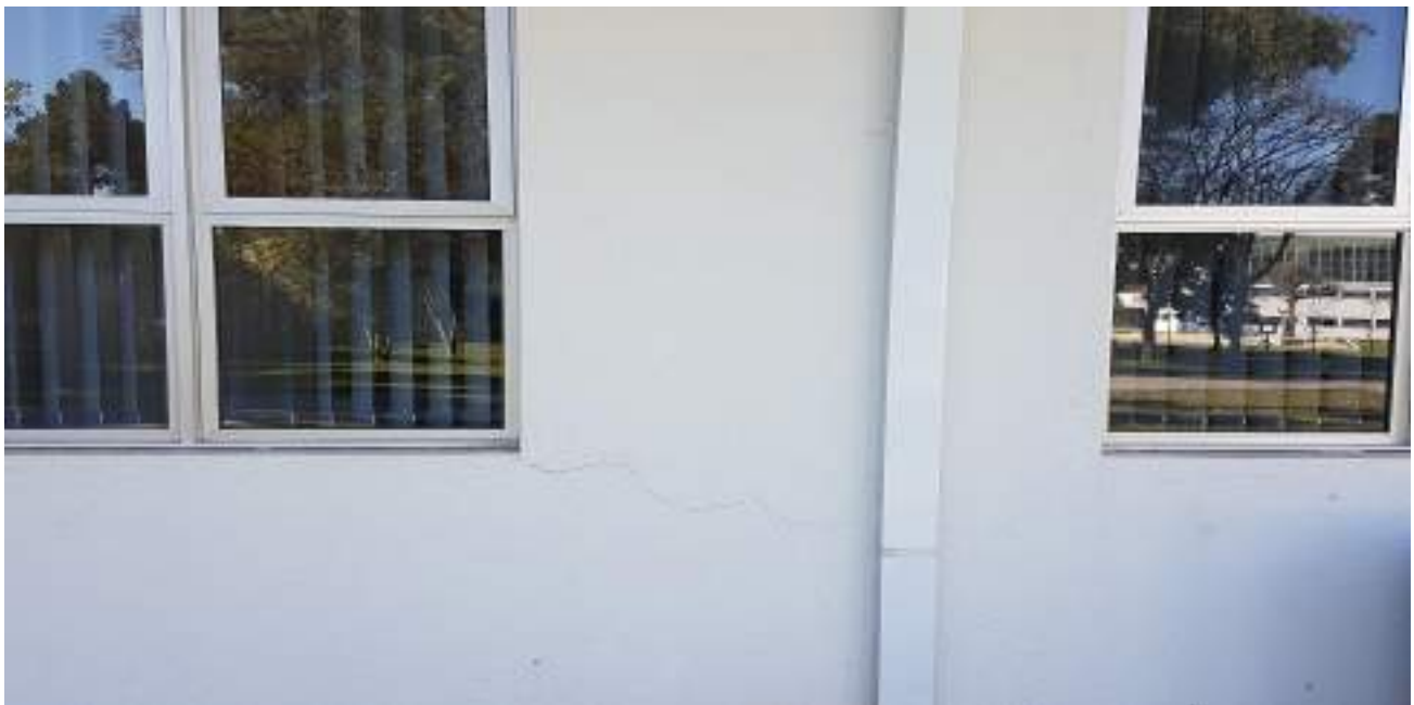
Imagem 6 - Localização: Parede lateral central do Prédio Anexo A
