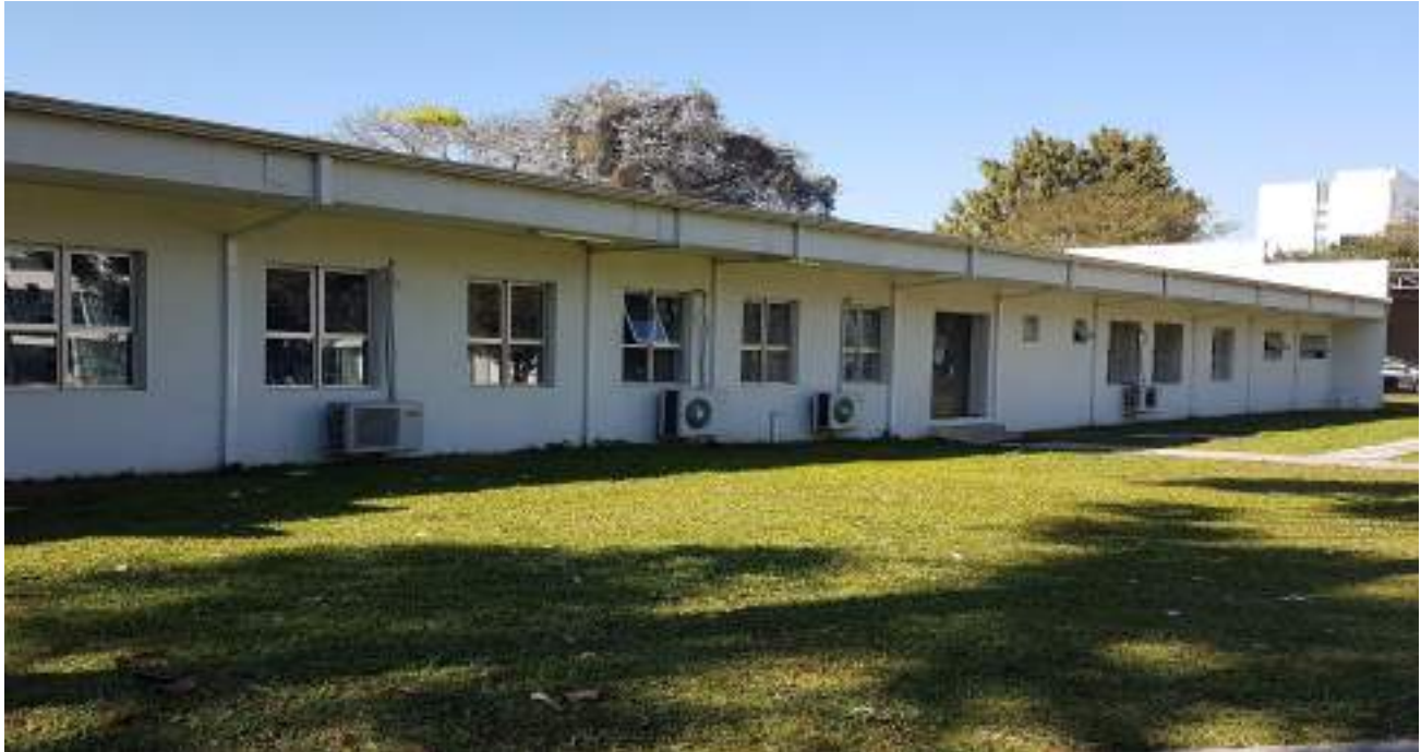
Imagem 5 - Localização: Lateral central do Prédio Anexo A.
