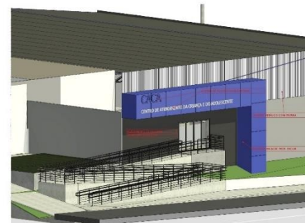
FACHADA ACM DC1:
