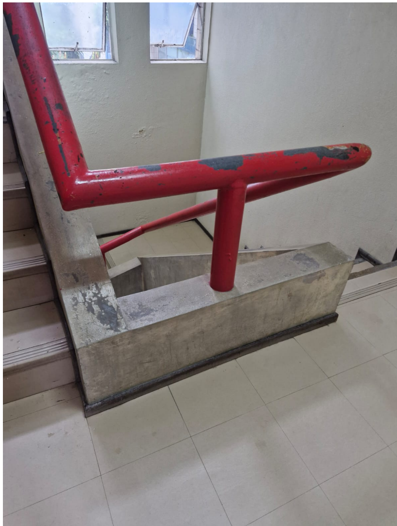
Figura 01. Escadas do prédio vertical do HUPAA, onde deverão ser instaladas as telas de proteção.
