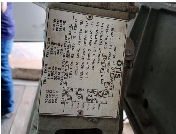
Figura 14. Placa de Identificação, demonstrando provável ano de partida 1991. Contudo os mesmos sofreram modernização entre os anos de 2015 e 2016. Fonte: Acervo Técnico, 2025
