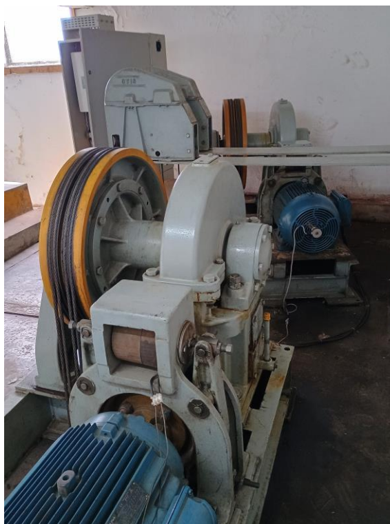
Figura 13. Conjunto motor/polia (casa de máquinas dos elevadores sociais – todas as casas de máquinas seguem o mesmo padrão). Fonte: Acervo Técnico, 2025
