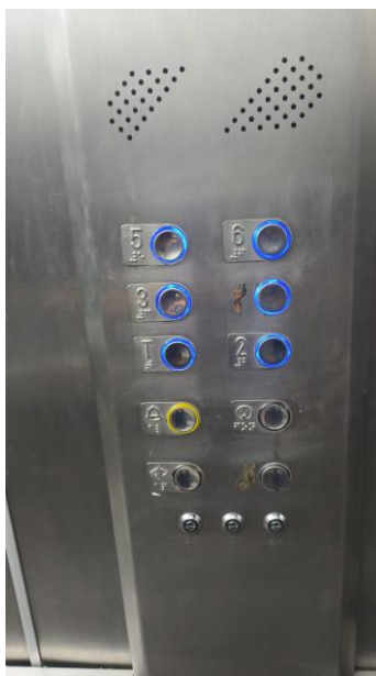
Figura 11. Botão de chamada padrão para todos os elevadores. Fonte: Acervo Técnico, 2025
