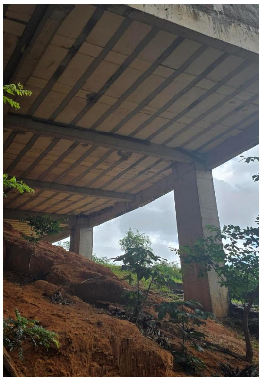
FOTO II – LOCAL A SER EXECUTADA A ESTRUTURA DE CONTENÇÃO
