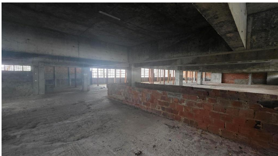
FOTO III – PAVIMENTO INTERNO DA EDIFICAÇÃO
