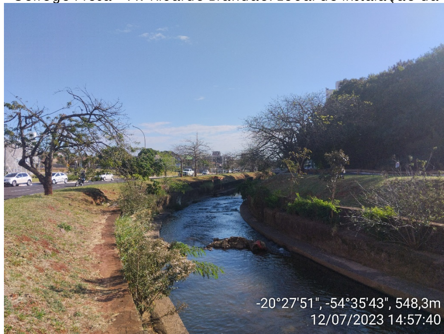
Foto 03 – Córrego Prosa – Av Ricardo Brandão. Local de instalação da travessia.
