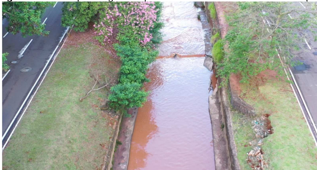
Figura 11 – Rodapé margem esquerda a reformar com concreto ciclópico
