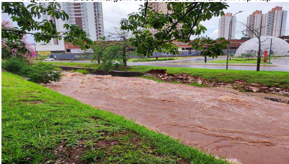
Figura 9 – Talude margem esquerda a reformar com Rip-Rap
