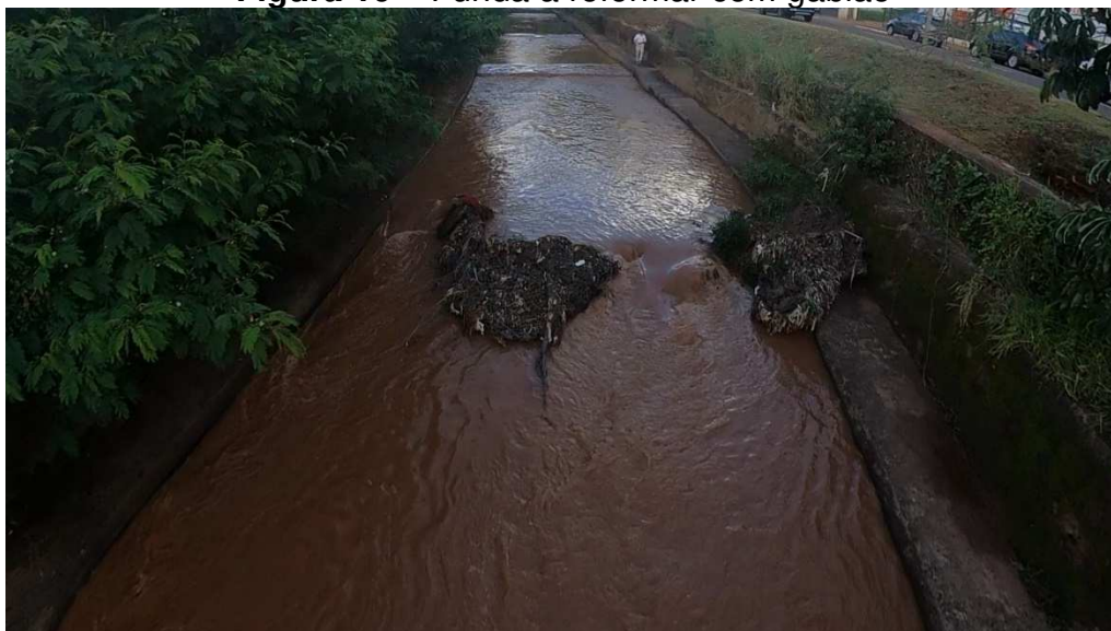
Figura 10 – Funda a reformar com gabião
