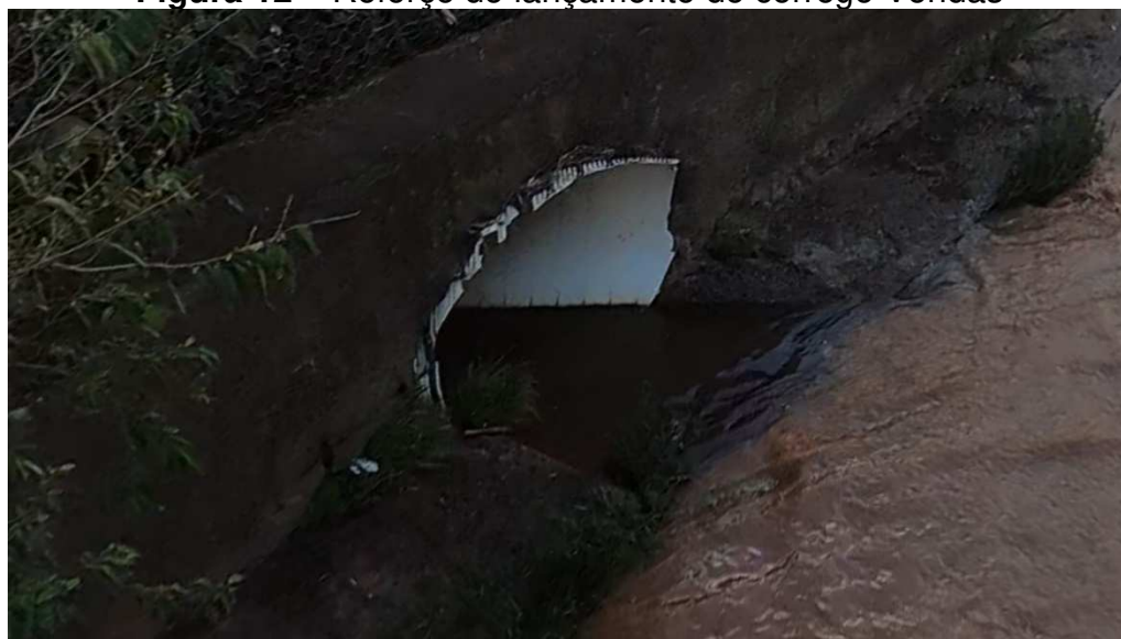
Figura 12 – Reforço do lançamento do córrego Vendas
