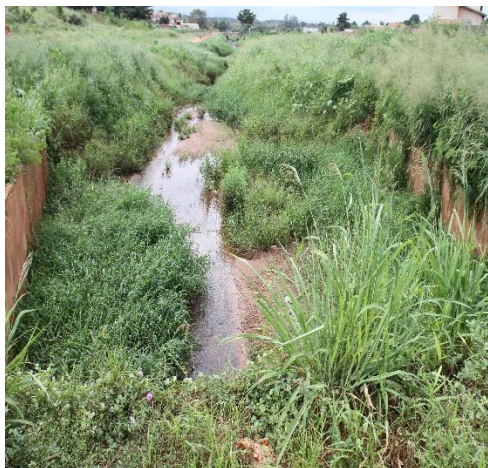
Foto 04: Bueiro triplo da Av. César lançado no Córrego Fazendinha
