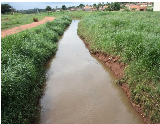
Foto 02: Canal do Córrego
