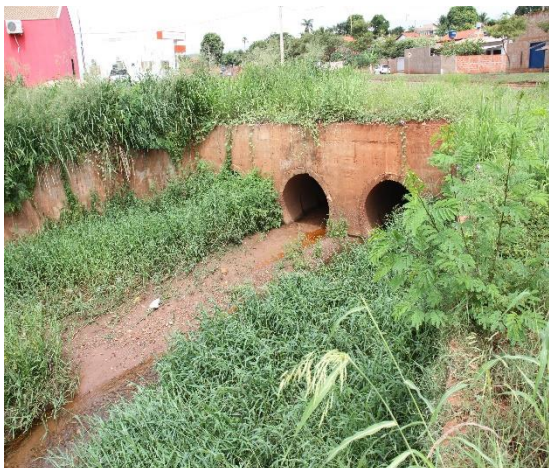
Foto 03: Bueiro triplo da Av. César Mancini lançado no Córrego Fazendinha
