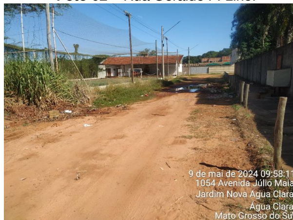
Foto 02 – Rua Geraldo F. Lino.
