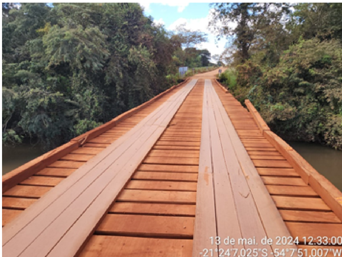
Imagem 05 – Ponte em madeira sobre o Rio Anhanduí - Rodovia CG-342
