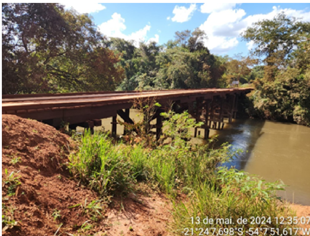
Imagem 03 – Ponte em madeira sobre o Rio Anhanduí - Rodovia CG-342
