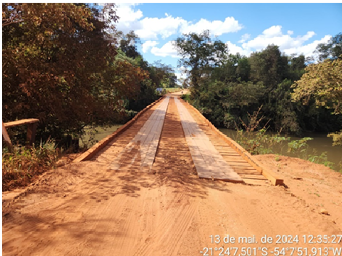
Imagem 04 – Ponte em madeira sobre o Rio Anhanduí - Rodovia CG-342
