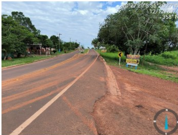
Foto 2: Rodovia MS-450 – Distrito de Palmeiras
