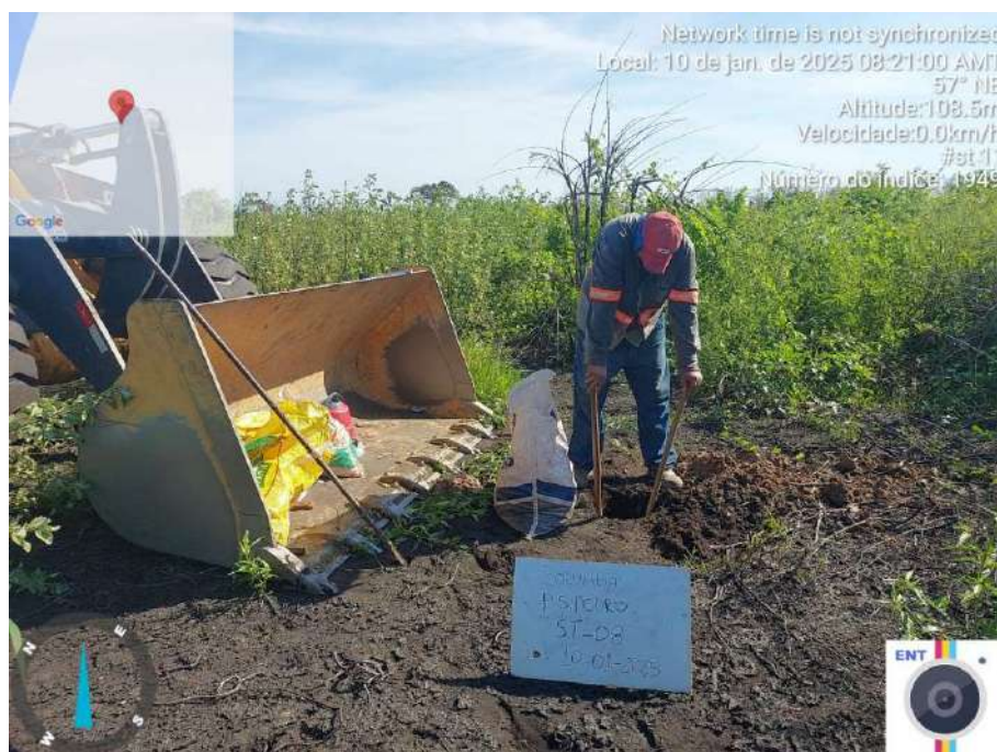
Figura 30 – Execução do Furo 08
