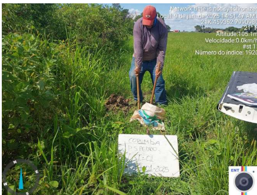
Figura 17 – Execução do Furo 01
