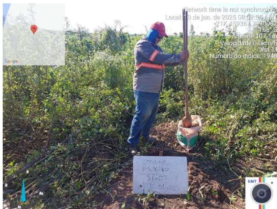
Figura 28 – Execução do Furo 07
