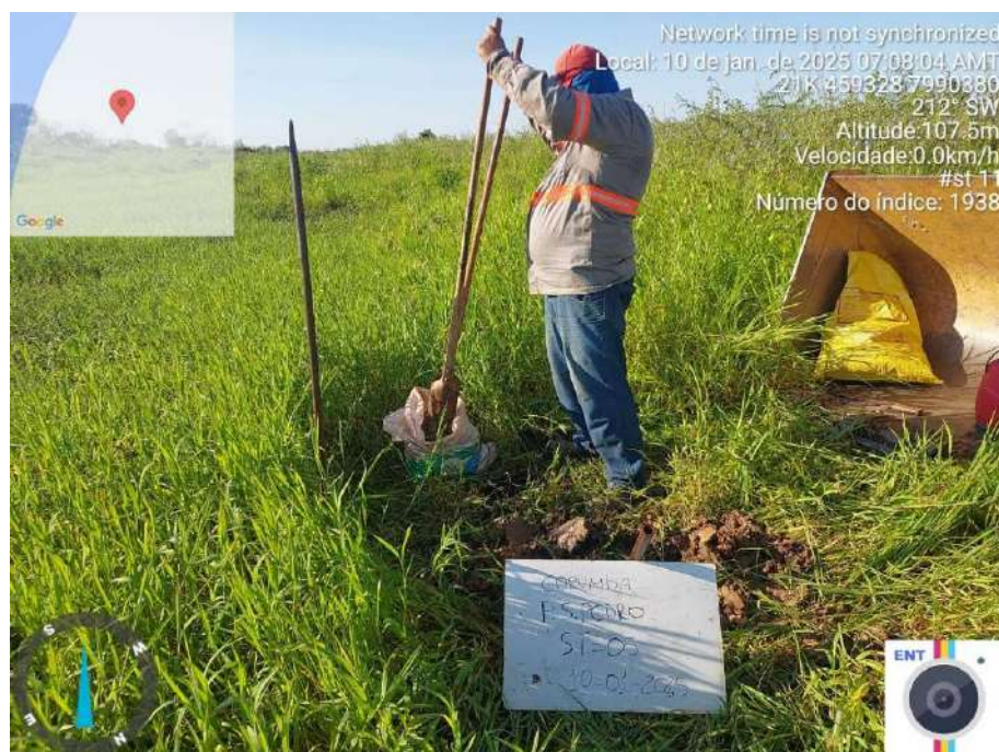
Figura 23 – Execução do Furo 05
