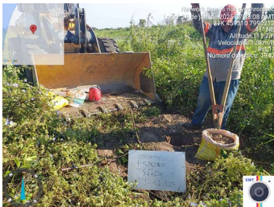
Figura 25 – Execução do Furo 06
