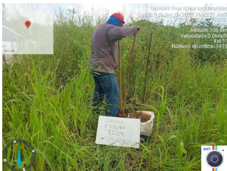
Figura 22 – Execução do Furo 04
