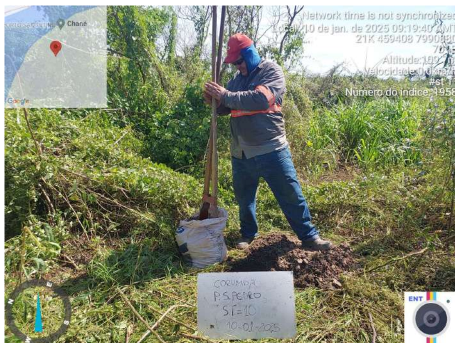
Figura 32 – Execução do Furo 10
