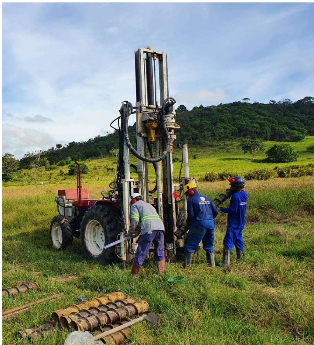
Figura 15 – Execução de Sondagens a Trado
