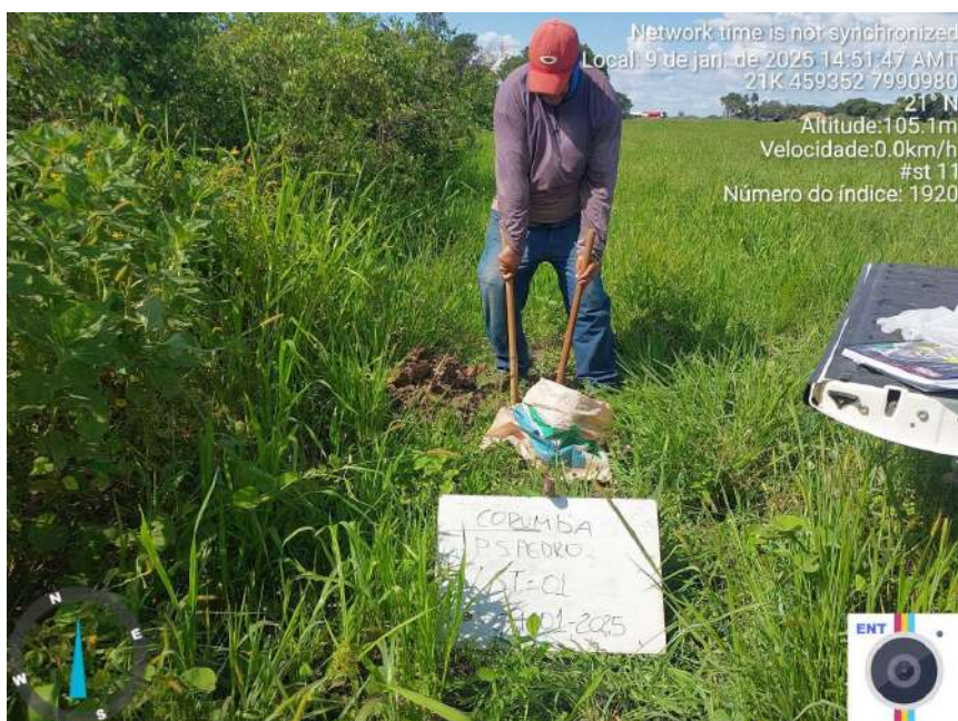
Figura 18 – Execução do Furo 01
