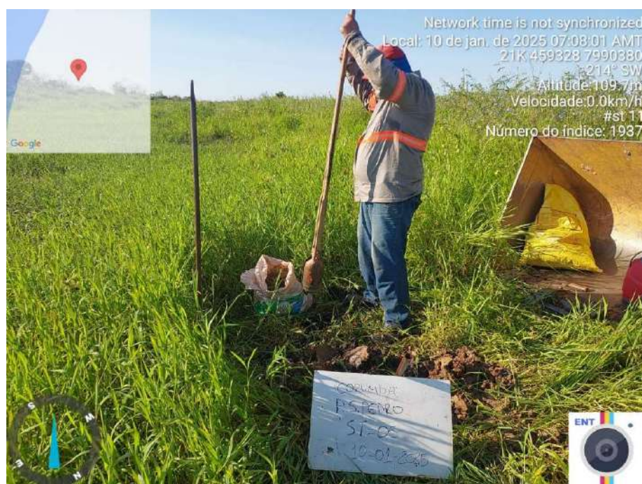
Figura 24 – Execução do Furo 05
