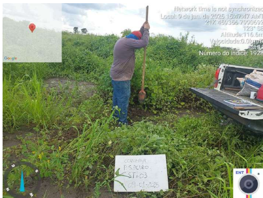
Figura 21 – Execução do Furo 03
