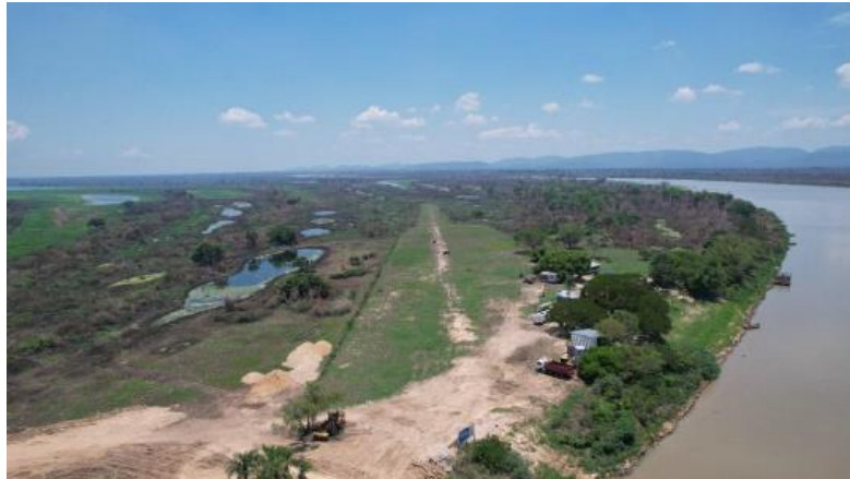
Figura 6. Vista aérea atual da Pista - São Pedro (Fonte: INFRAMS)
