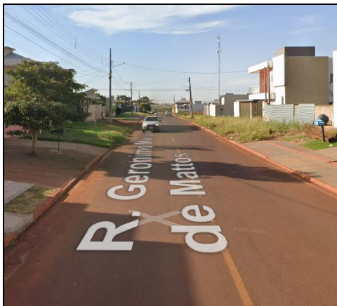
Foto 01 - Rua Gerônimo de Mattos – Bairro Santa Fé.
