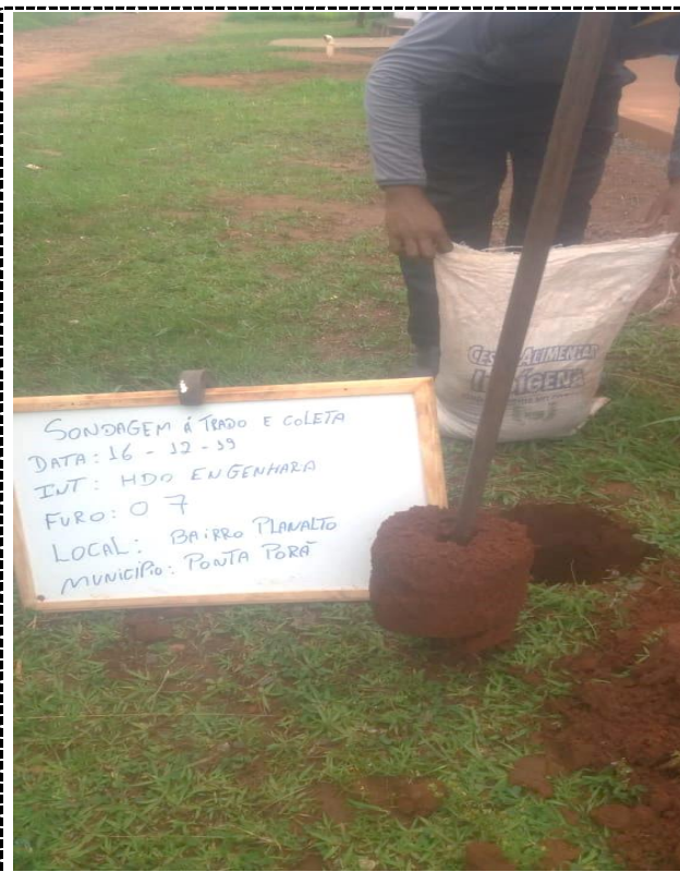
Descrição: Sondagem a trado e, coleta do solo para ensaio de caracterização no laboratório.
