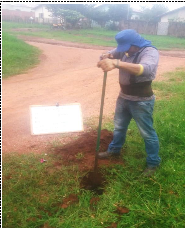
Descrição: Sondagem a trado e, coleta do solo para ensaio de caracterização no laboratório.
