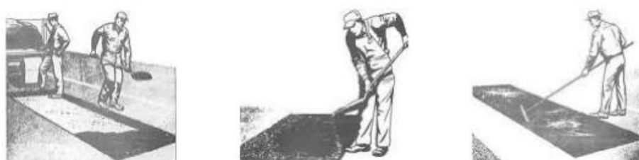
Figura 5: Enchimento de Caixa.
