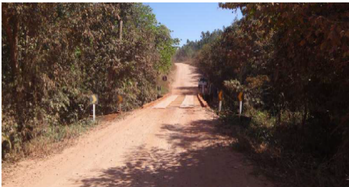
Imagem 03 – Ponte sobre o Córrego Baguaçu - Rodovia MS-244.
