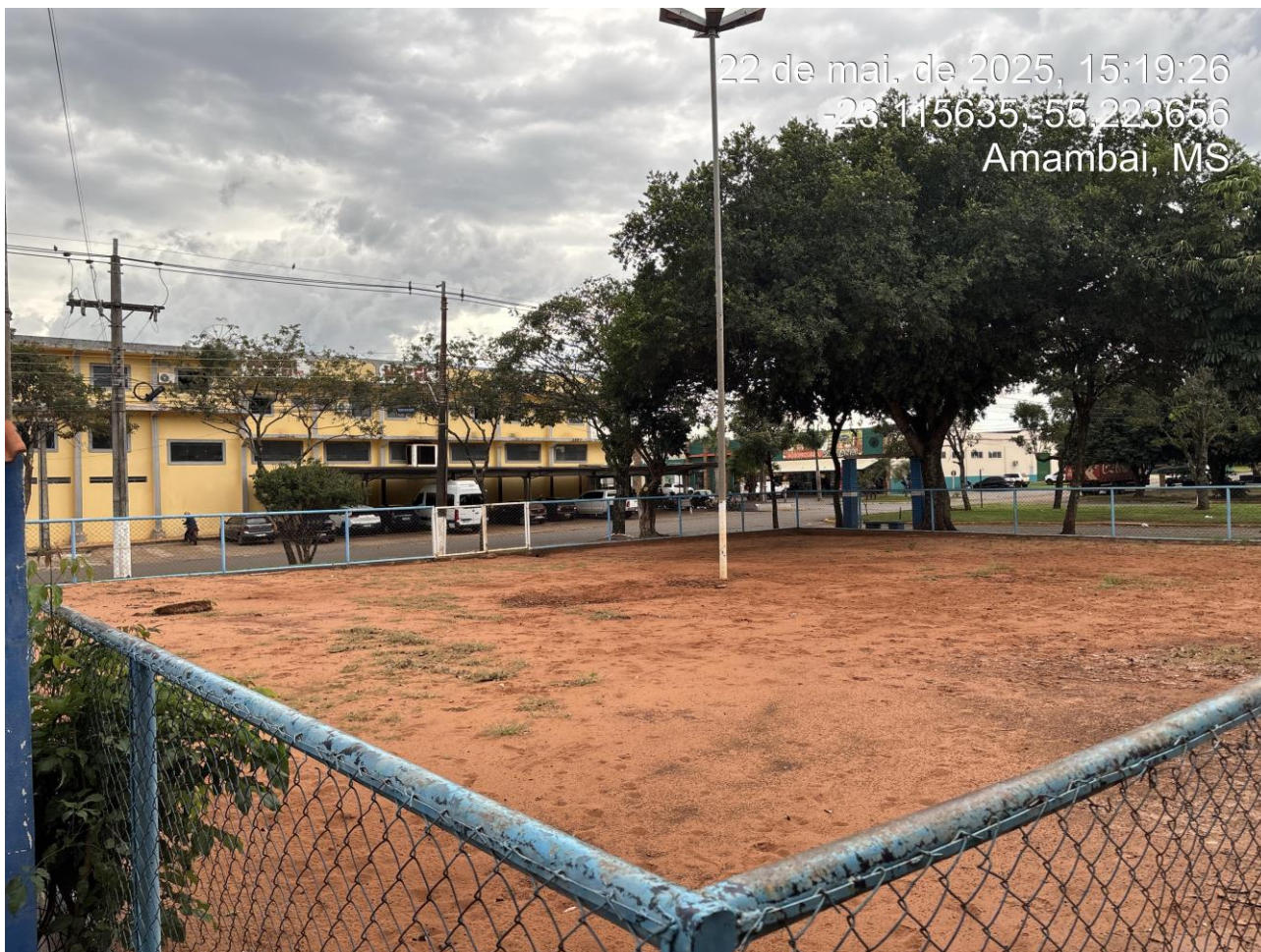
FOTO 05 – IMAGEM ARRUAMENTO INTERNO
