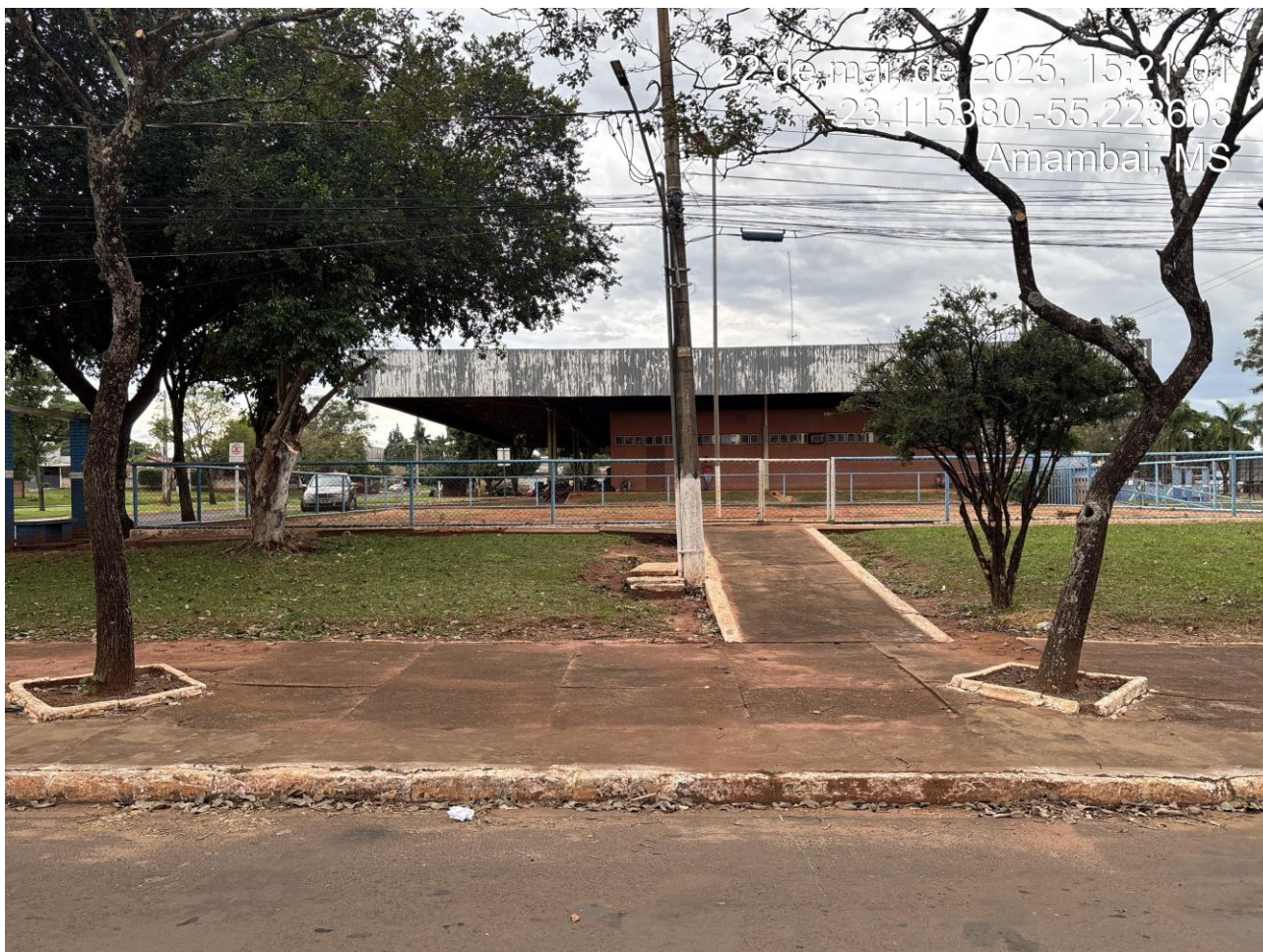
FOTO 01 – IMAGEM FRONTAL NA RUA ARI NUNES
